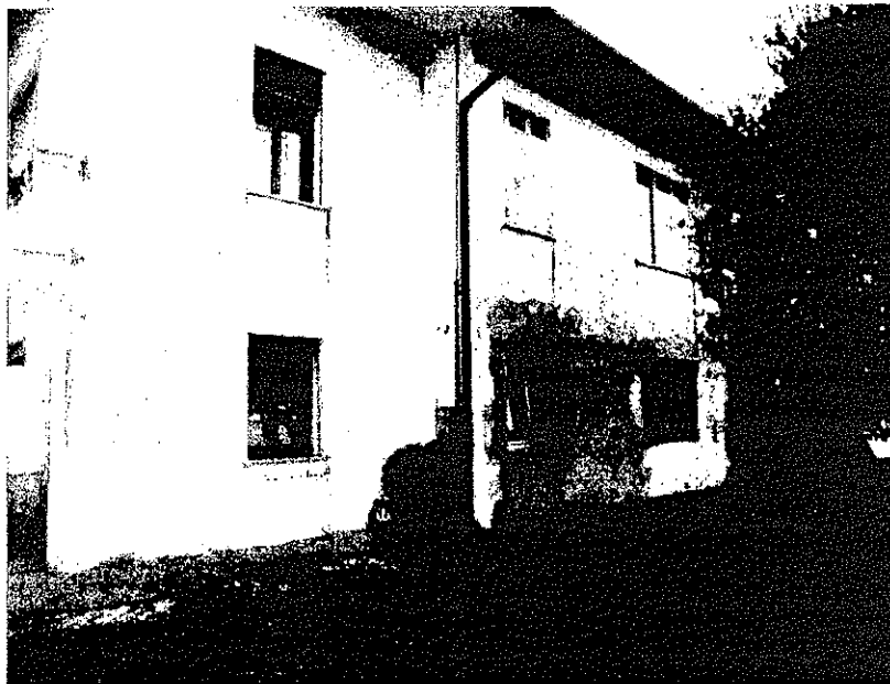
FOTO 7: vista prospetto est fabbricato residenziale
