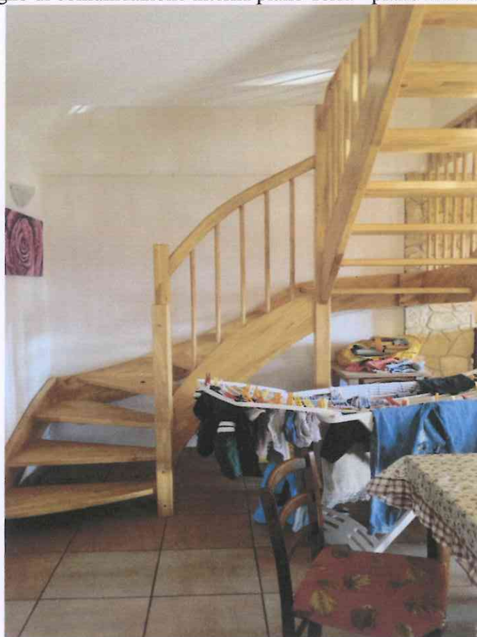
Particolare scala in legno di comunicazione interna piano Terra - piano Primo
