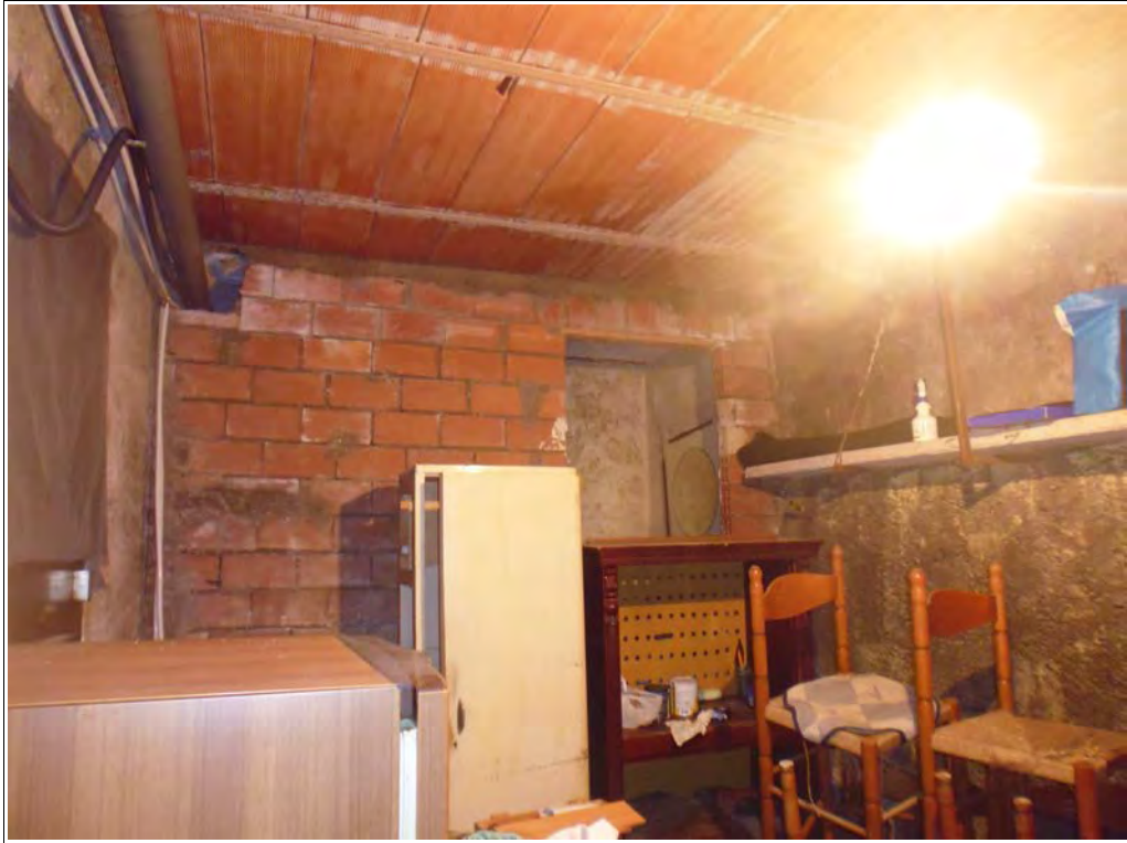
Foto 5 – Locale cantina piano terra
