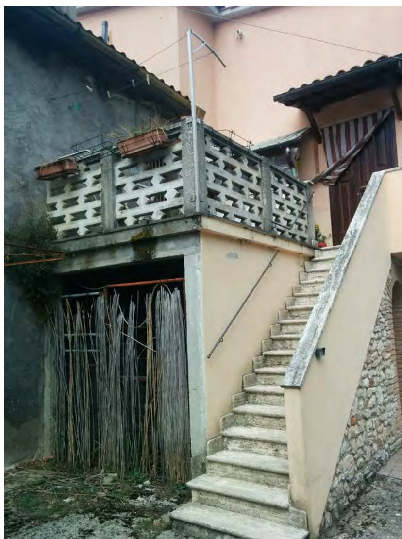
Foto 13 – Vista esterna ripostiglio sotto la terrazza
