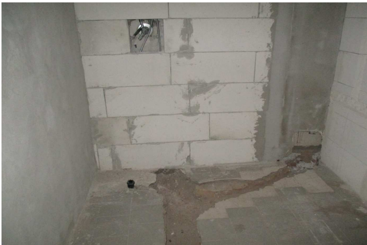
servizi zona magazzino in corso di realizzazione
