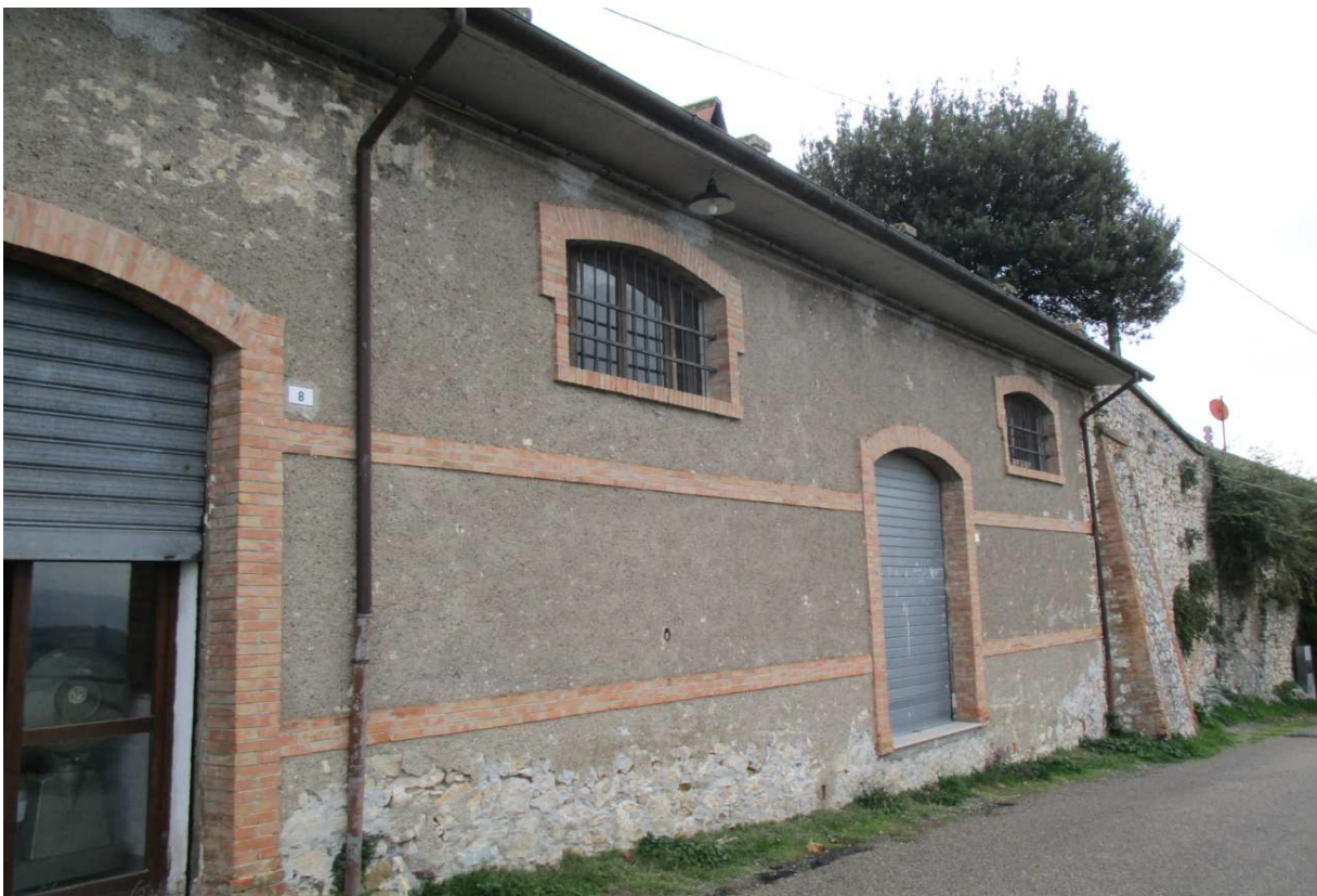
facciata fabbricato a valle
