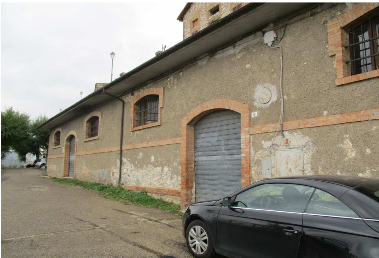
facciata fabbricato a monte
