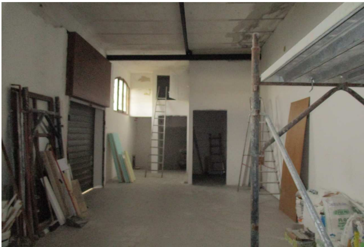
interno magazzino (sub.1) con lavori in corso
