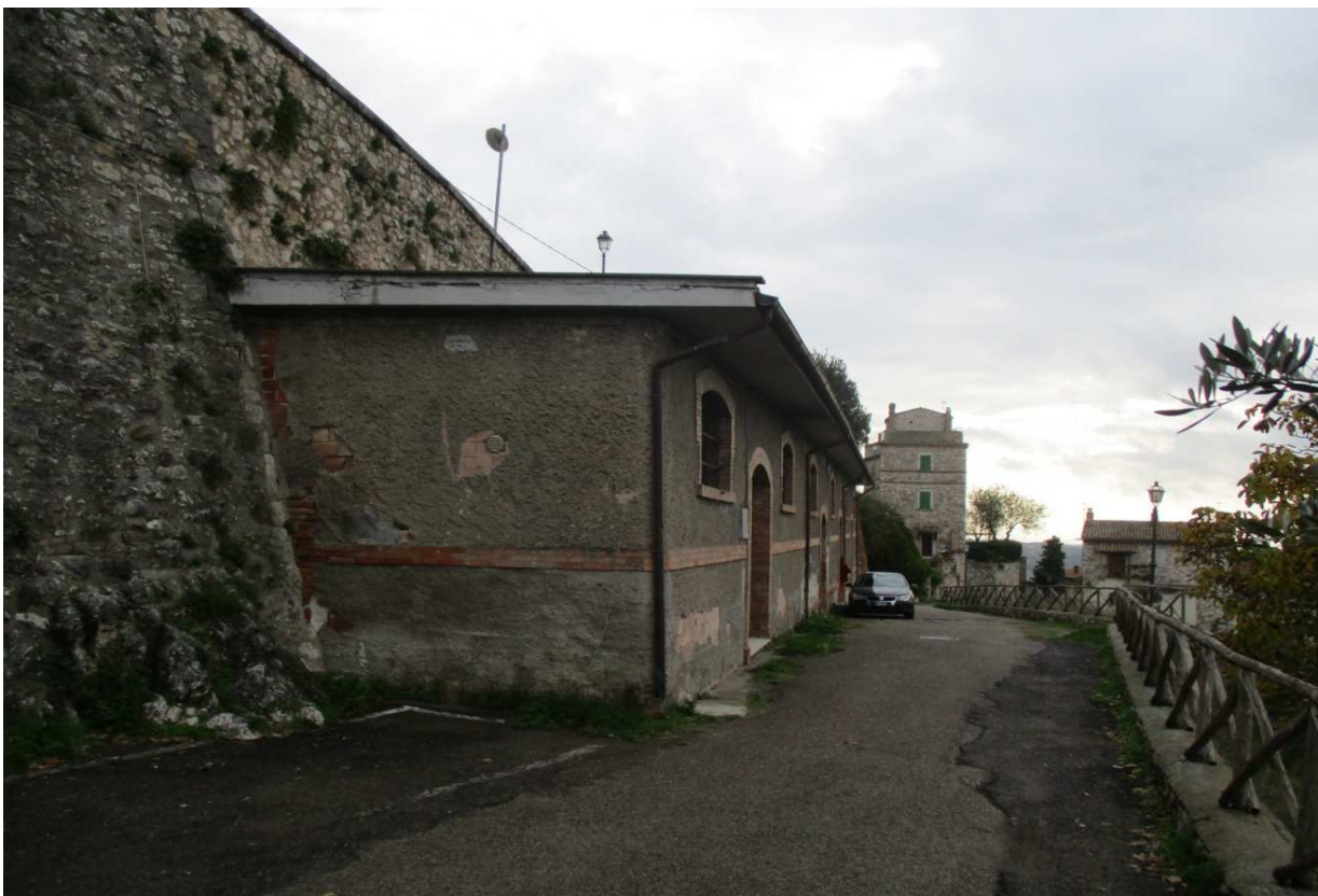
vista laterale esterna fabbricato
