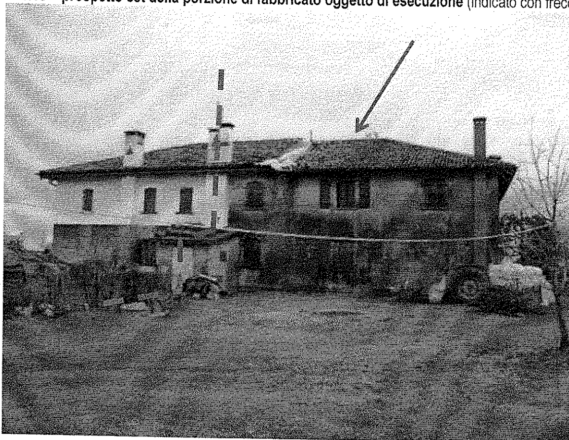
Foto 1.13 – prospetto est della porzione di fabbricato oggetto di esecuzione (indicato con freccia rossa)
