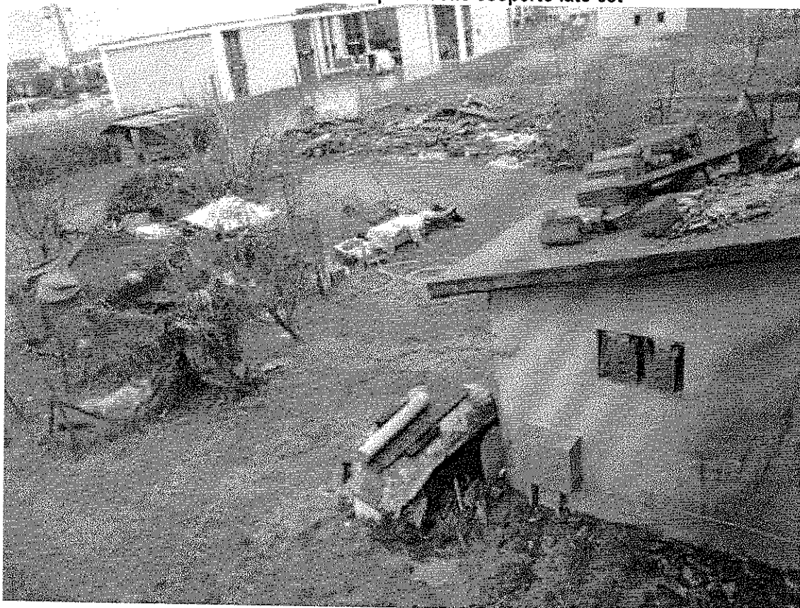
Foto 1.15 – vista di parte dello scoperto lato est
