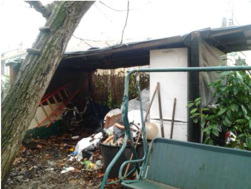
GIARDINO CON PARTICOLARE DELLA TETTOIA
