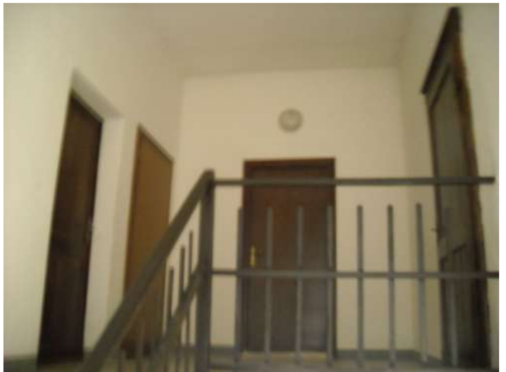
VANO SCALA A PIANO PRIMO
