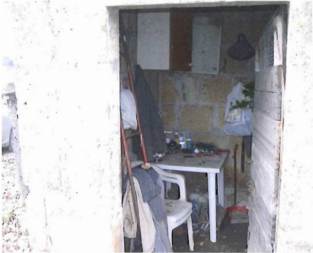
Illustrazione 8: particolare interno fabbricato in muratura
