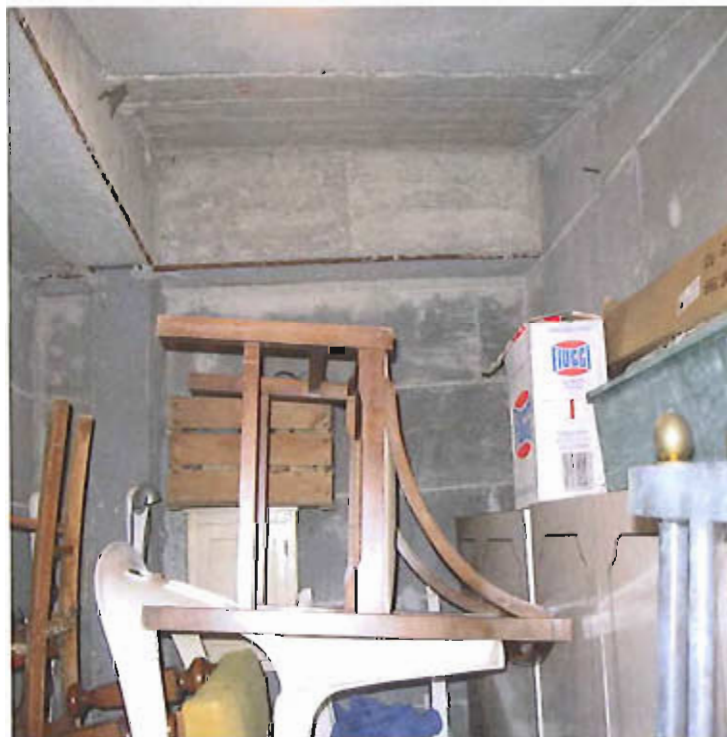
Illustrazione 9: particolare cantina
