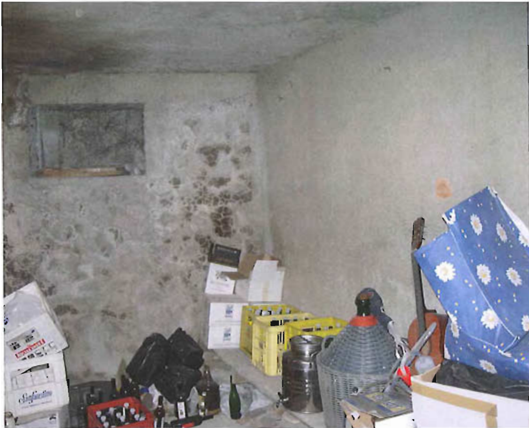
Illustrazione 11: particolare cantina
