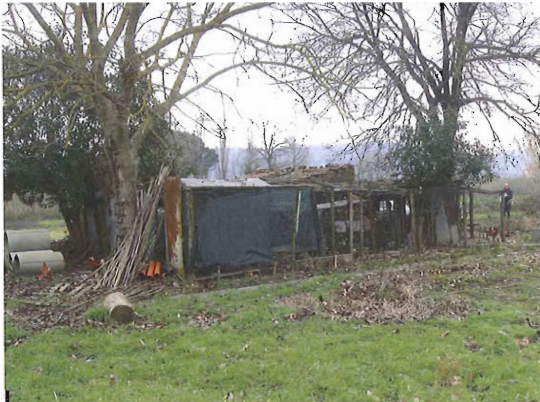
Illustrazione 7: manufatti in lamiera da demolire
