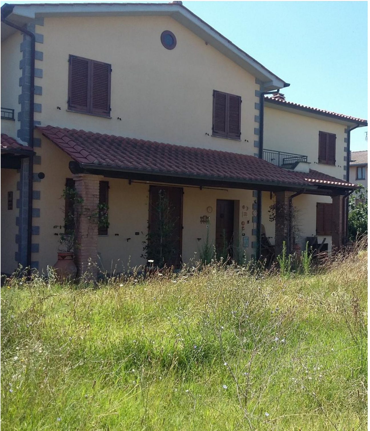
Foto 4: PROSPETTO NORD-OVEST DELL'ABITAZIONE
