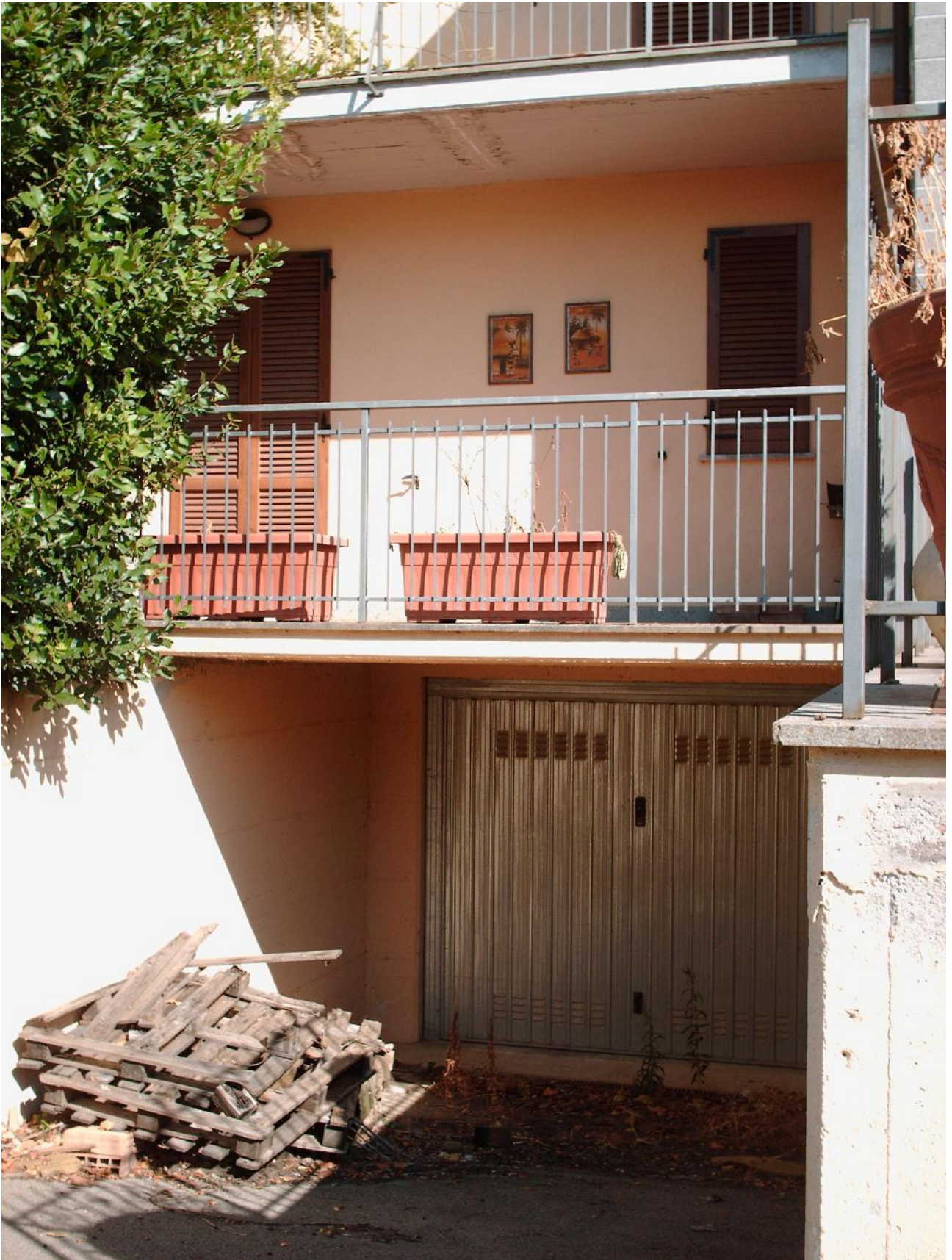
Foto 6: PROSPETTO SUD-EST DELL'ABITAZIONE; INGRESSO AUTORIMESSA
