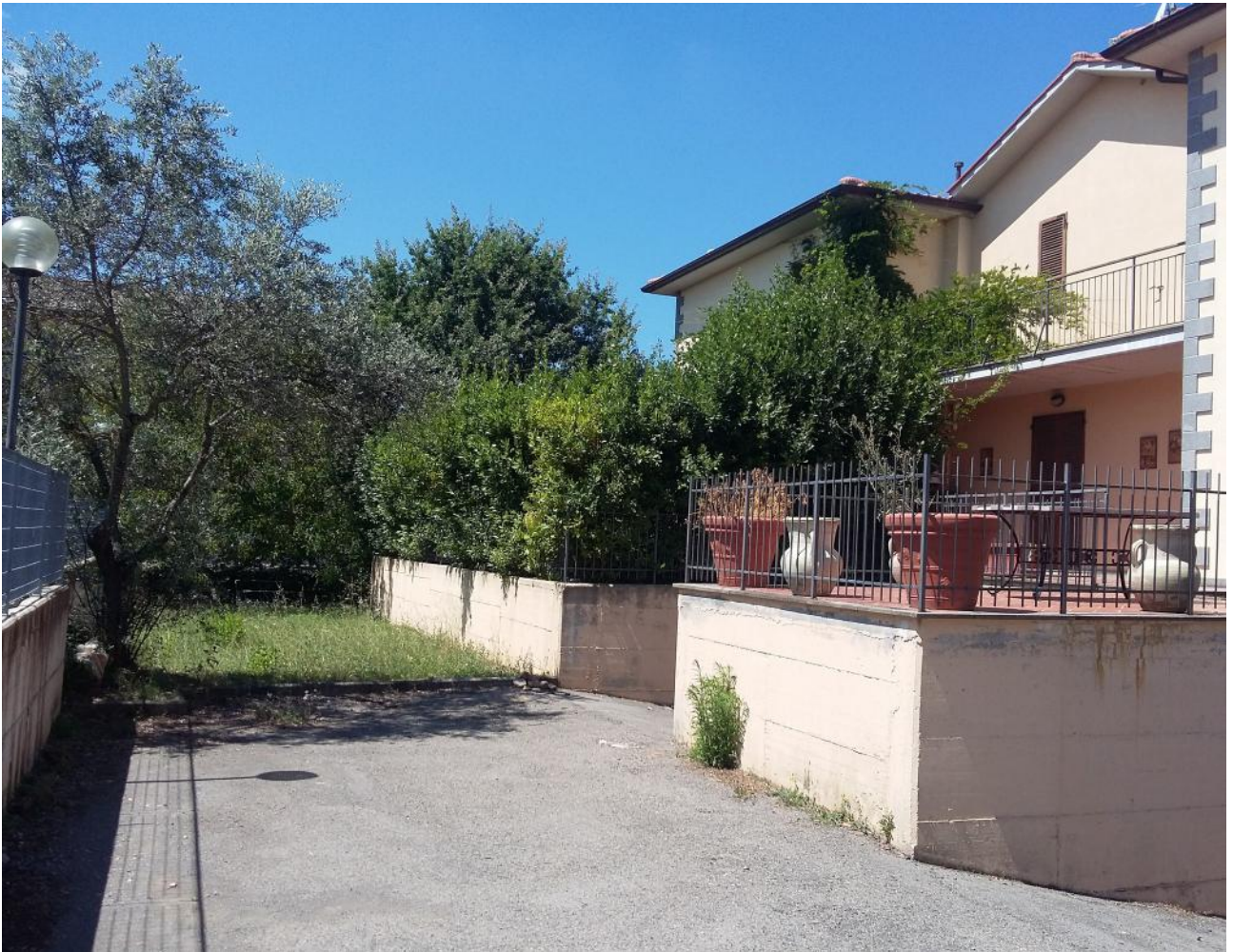
Foto 5: PROSPETTO SUD-EST DELL'ABITAZIONE
