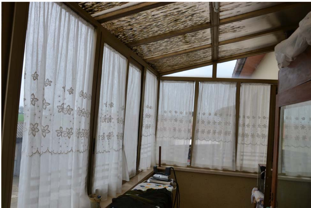
Balcone con veranda
