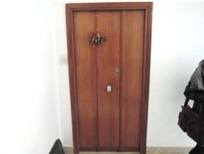
Portoncino di ingresso dell'appartamento
