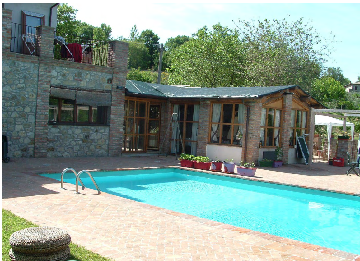
4) Particolare piscina e tettoia in muratura
