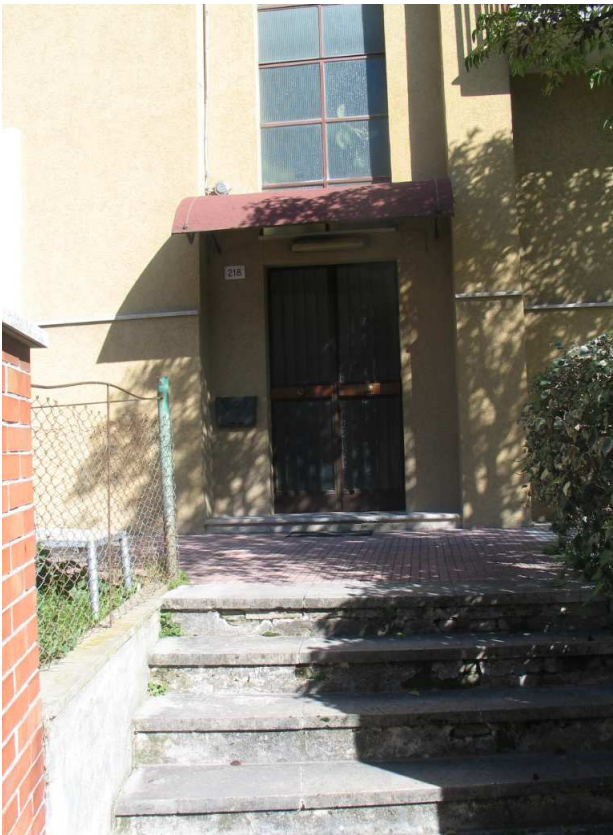
Foglio 87 part. 105 e 596: portone di accesso
