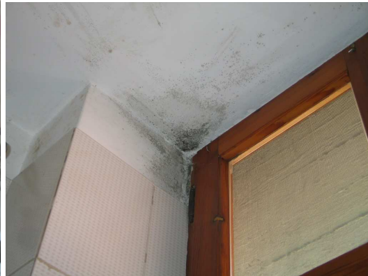
Foglio 87 part. 105 e 596: bagno principale, particolare di piccoli segni di umidità
