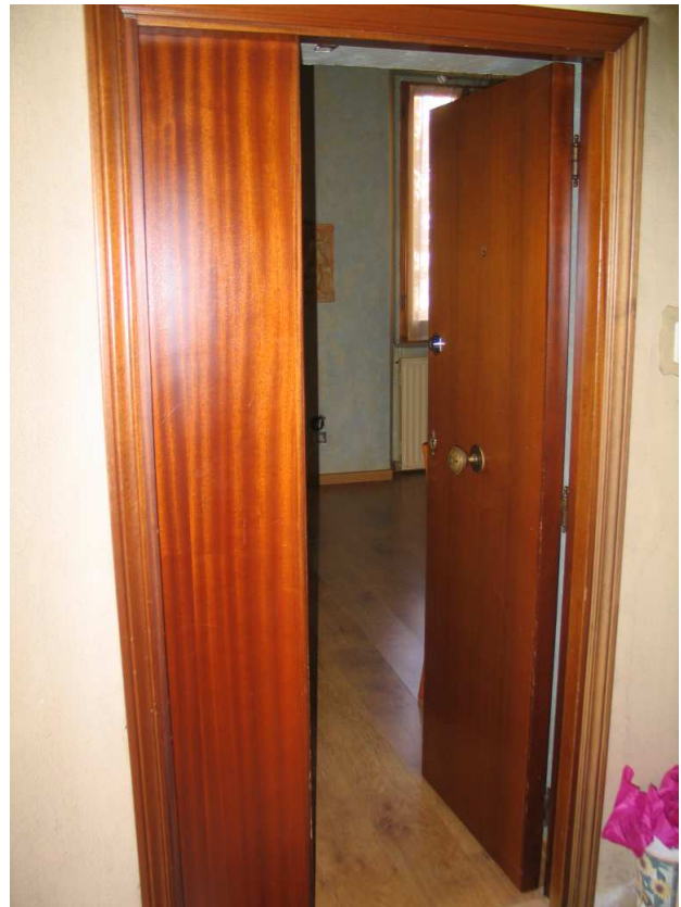
Foglio 87 part. 105 e 596: porta d'ingresso
