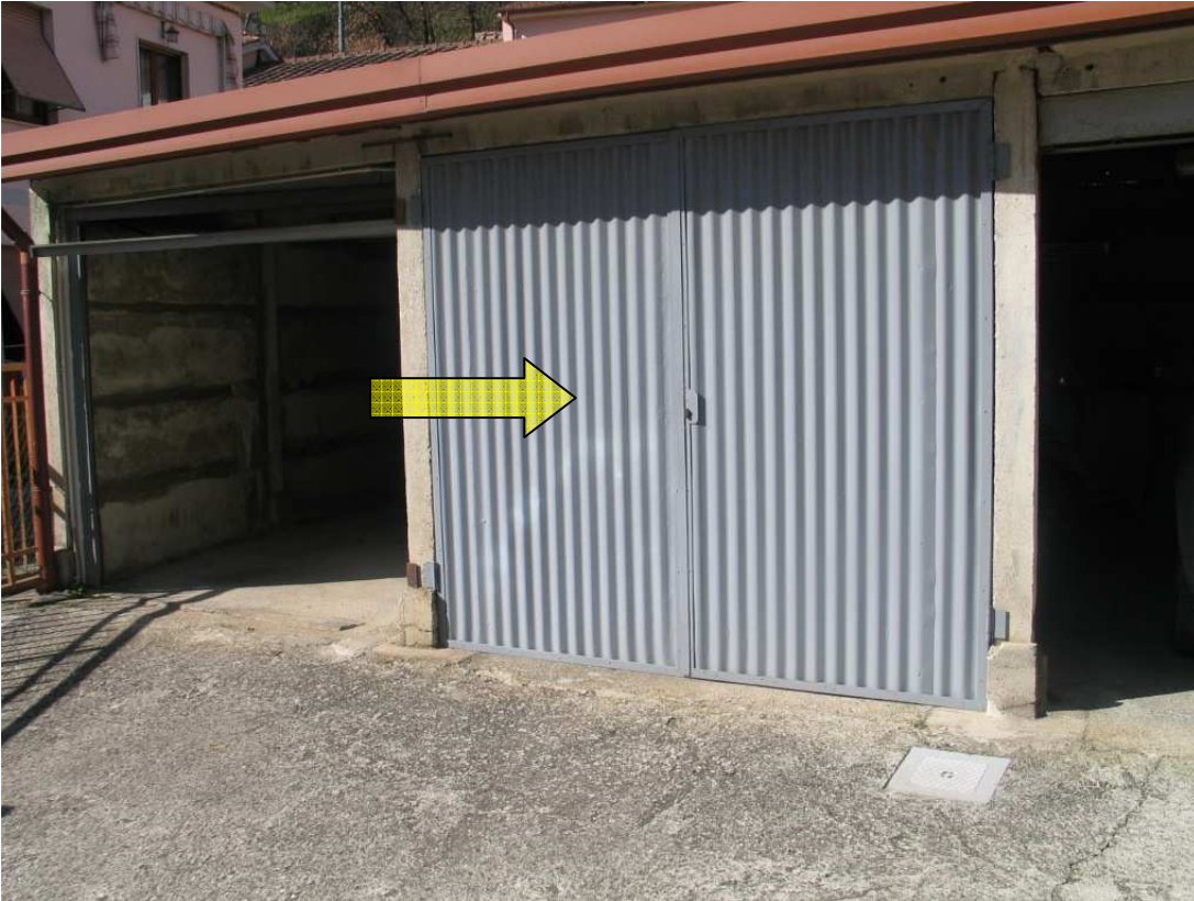
Foglio 87 part. 649. sub: 2: ingresso dell'autorimessa
