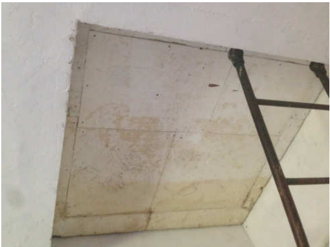
botola accesso al piano primo
