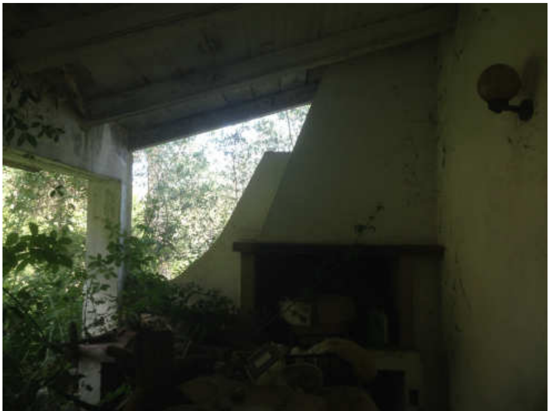
camino sottostante portico
