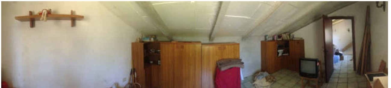
panoramica stanza n. 2 mansarda
