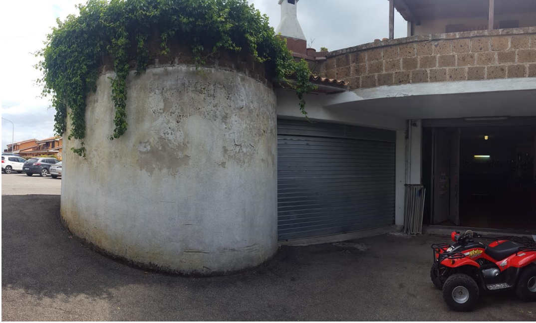
Ingresso pedonale dall'esterno ed al garage
