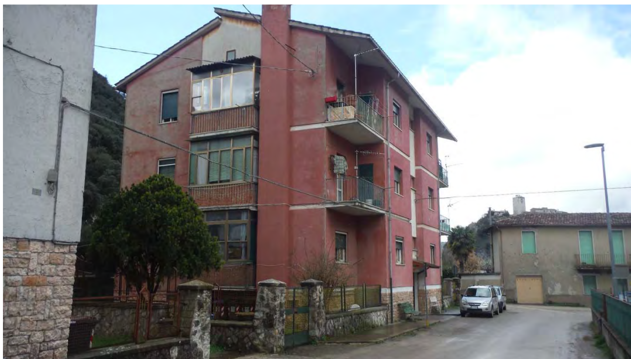
Foto 2 prospetto nord-est (alloggio al piano secondo – si noti la chiusura a vetri della loggia, condonata)
