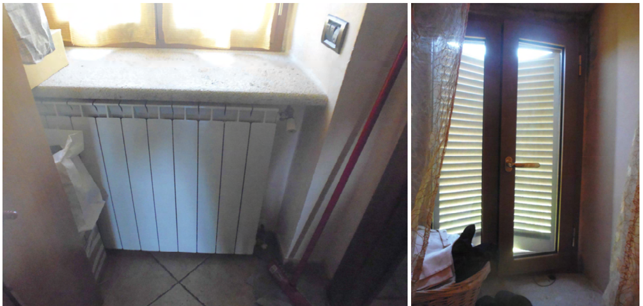
Vista 15 – 16 : Particolari (radiator corridoio e infissi camera da letto)
