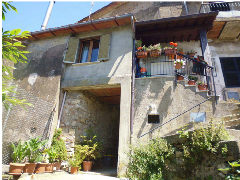
Vista 3: Accesso al locale cantina, Piano Seminterrato
