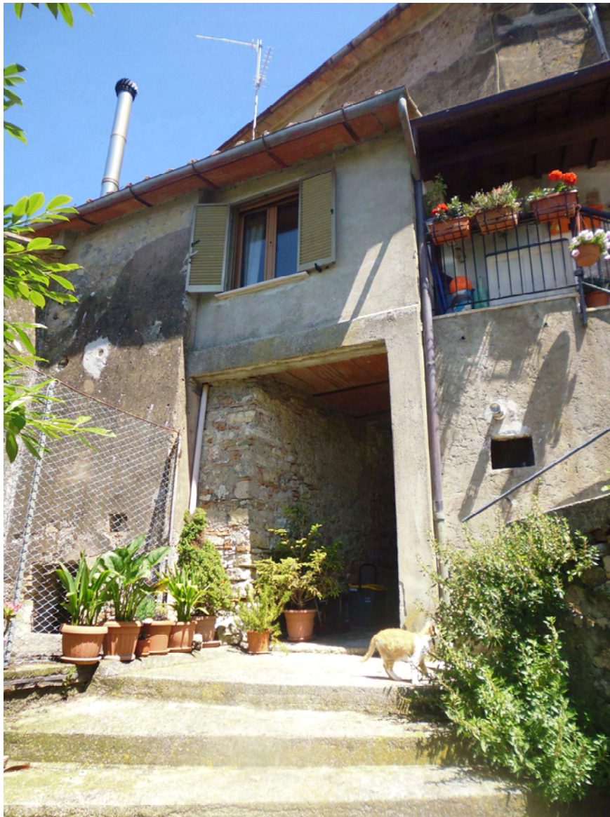
Vista 5: Accesso al locale cantina, Piano Seminterrato
