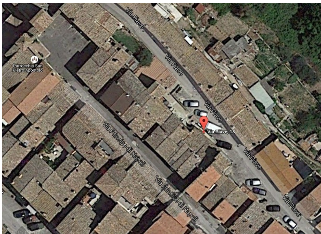
Foto n. 01: Vista aerea – Copertura
