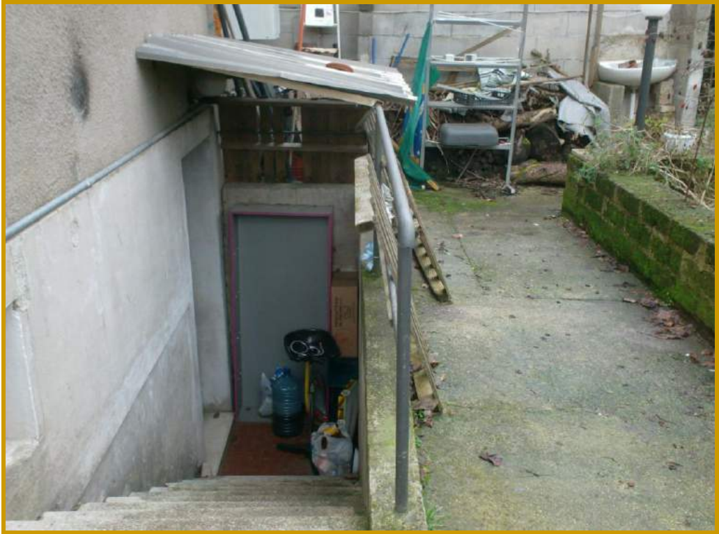
VISTA DELLA CORTE CON LA SCALA DI ACCESSO AL PIANO SEMINTERRATO
