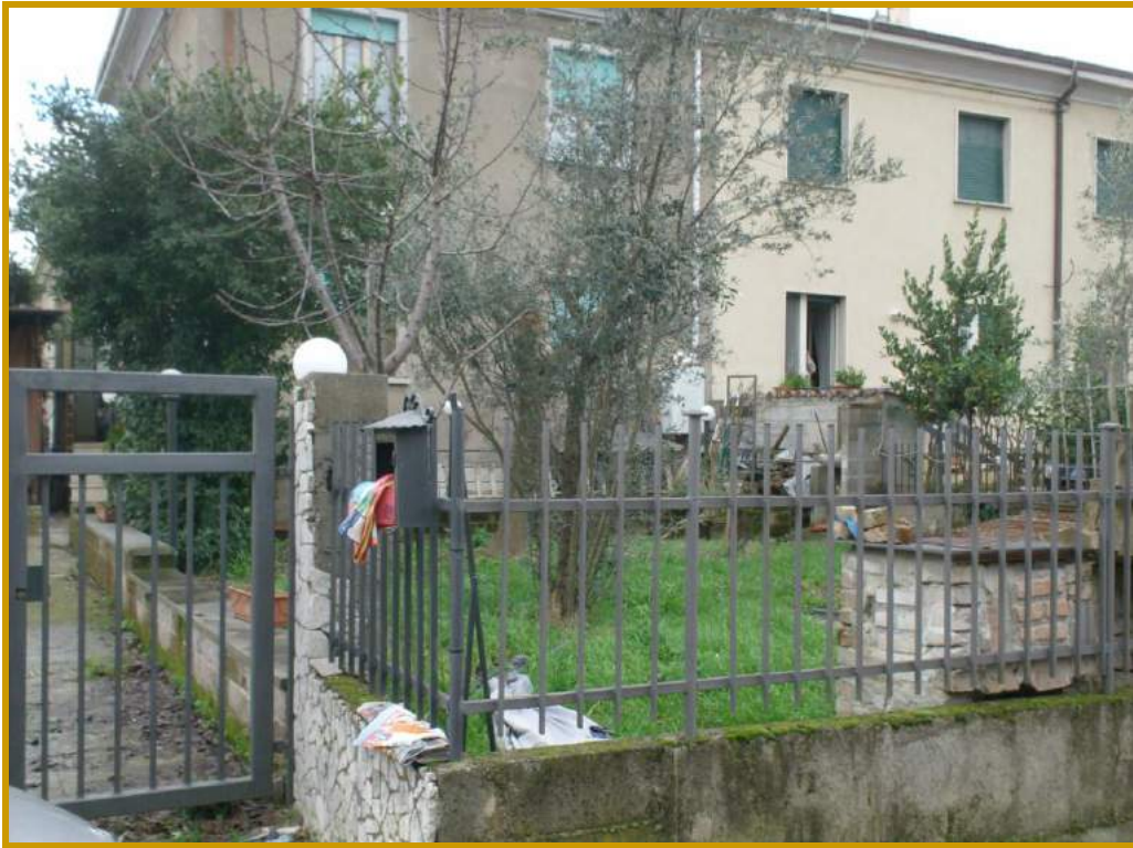
VISTA DEL PROSPETTO NORD E DELL'ACCESSO PEDONALE CON LA RECINZIONE DELLA CORTE
