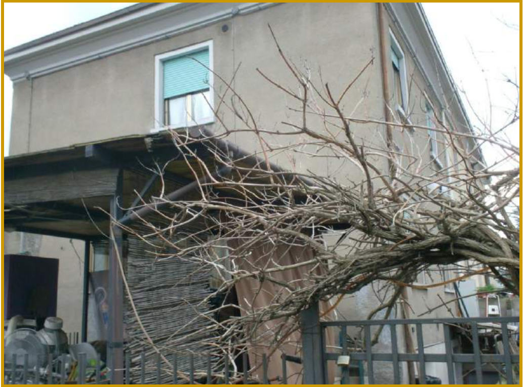
VISTA DEL PROSPETTO EST E DELLA TETTOIA
