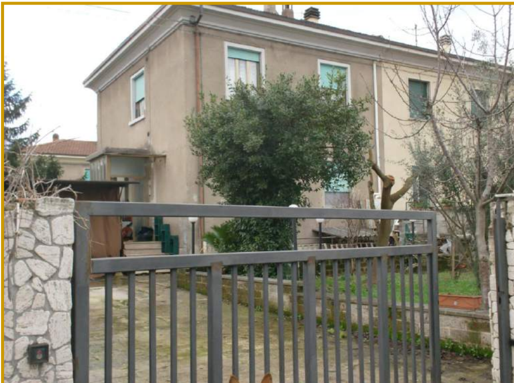
VISTA DEI PROSPETTI NORD ED EST CON L'ACCESSO CARRABILE ALLA PROPRIETA'
