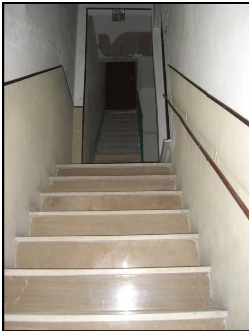
Vano scala di accesso all'unità immobiliare
