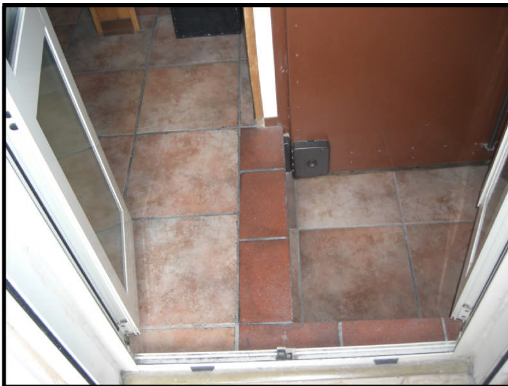
Particolare ingresso unità immobiliare
