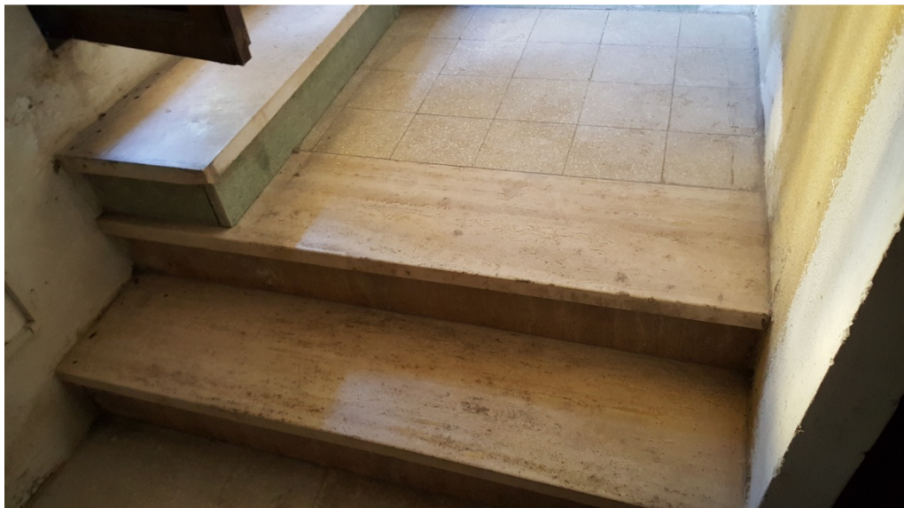
VISTA INTERNA VANO SCALA DI ACCESSO ALLA CANTINA
