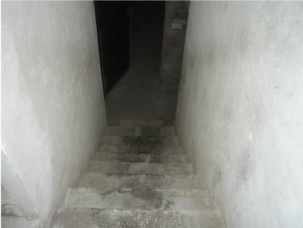
VISTA INTERNA VANO SCALA DI ACCESSO ALLA CANTINA
