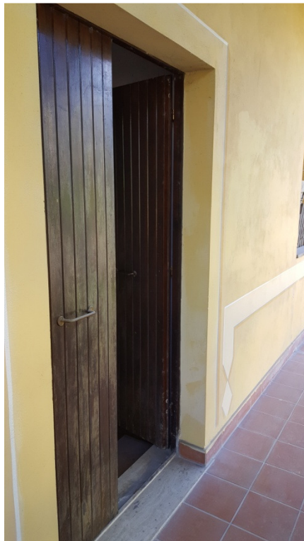
VISTA ESTERNA PORTA VANO SCALA
