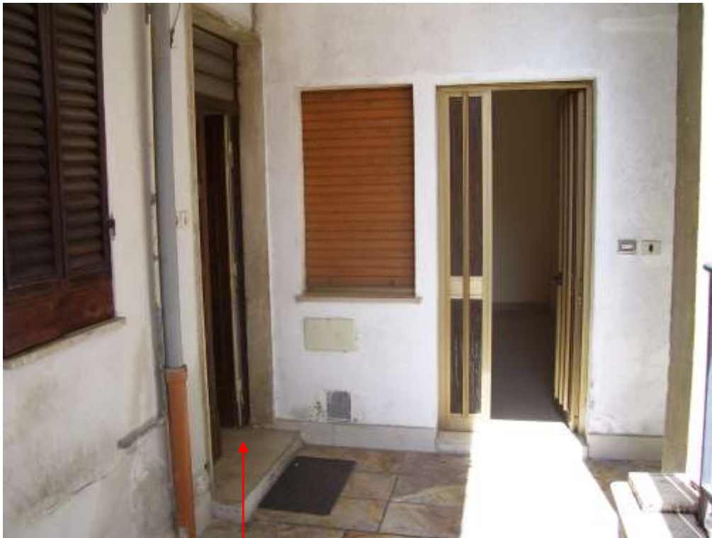
Ingresso appartamento Corpo B
