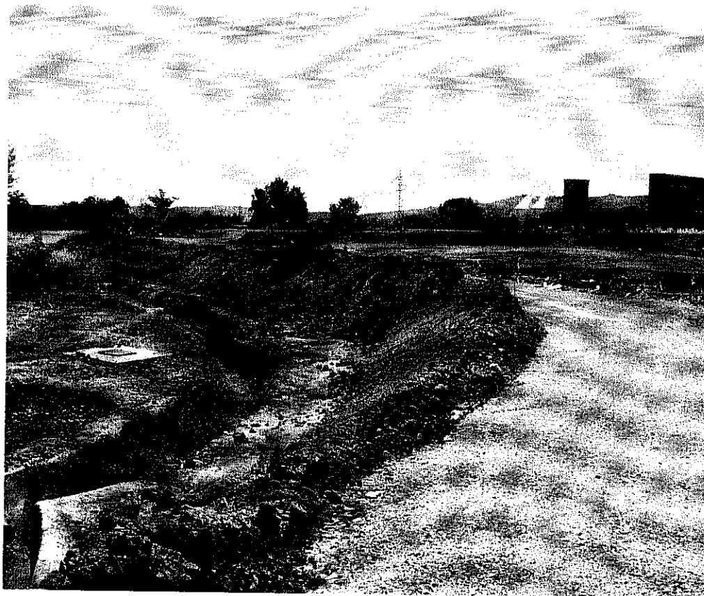
16) Lavori per la costruzione di una strada pubblica su particella n. 377 (espropriata)
