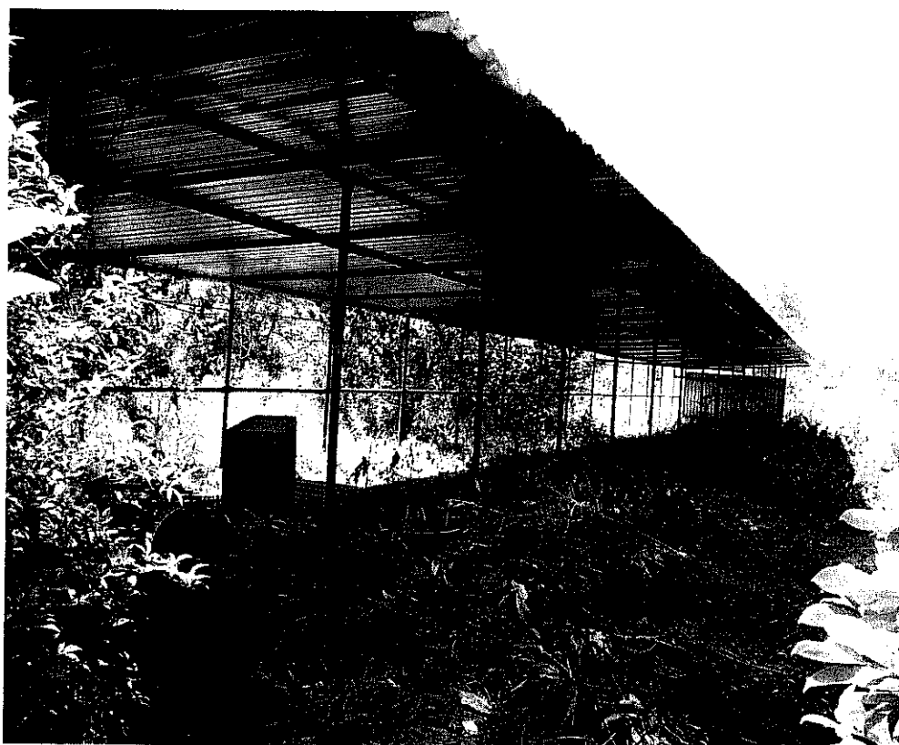
15) Tettoia in metallo non autorizzata (particella n. 23)
