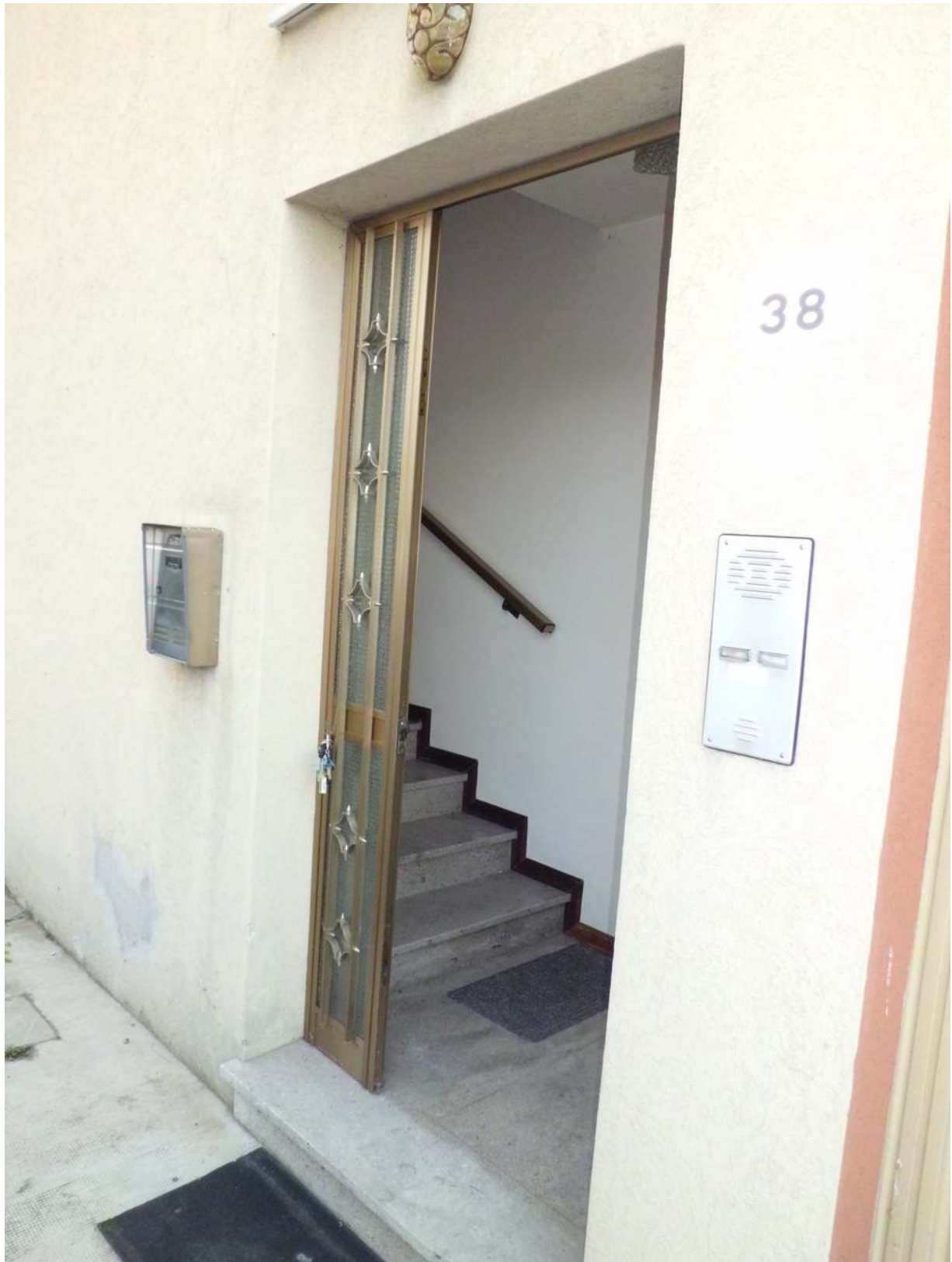
Foto n° 3 - 01/07/2016 - Comune di San Quirino, foglio 59, part. 57 – Portoncino esterno che si affaccia sull'area di pertinenza dell'edificio: all'interno sono visibili le scale che conducono all'appartamento pignorato (sub.3).
