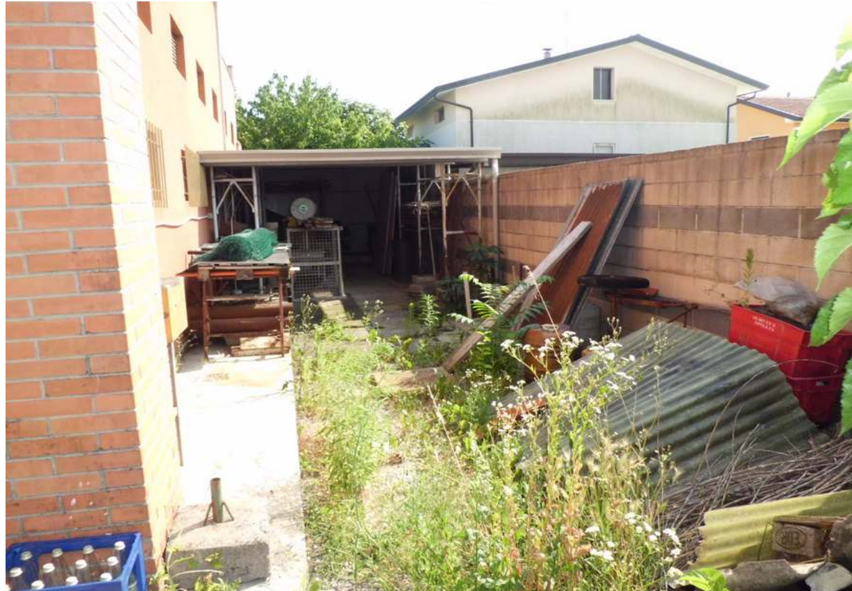
Foto n° 2 - 01/07/2016 - Comune di San Quirino, foglio 59, part. 57 e 74 - Veduta del retro dell'edificio. In fondo è visibile la tettoia per il ricovero attrezzi ricadente sia sulla particella 57 che sulla particella 74 del foglio 59.
