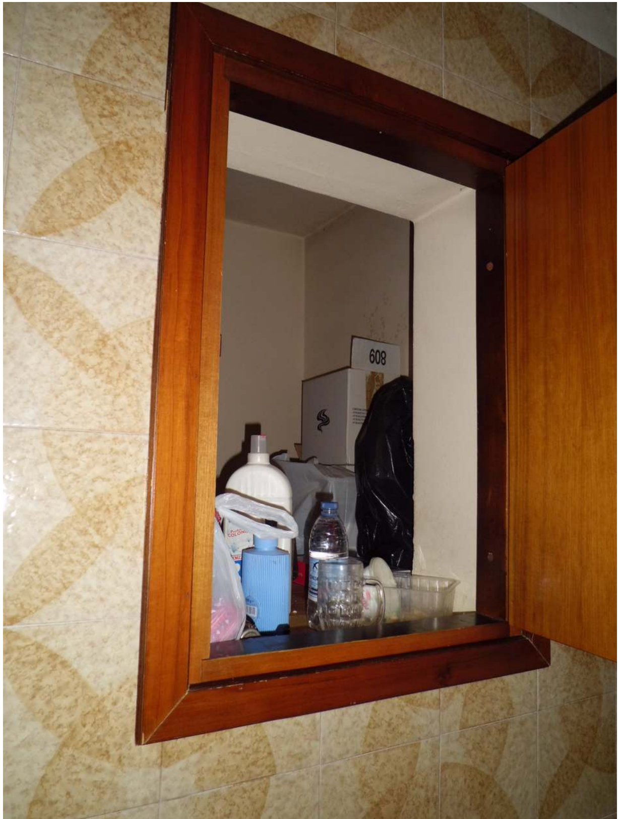
Foto n° 22 - 01/07/2016 - Comune di San Quirino, foglio 59, part. 57 sub.3 - Vano utilizzato come ripostiglio, presente nella parete del bagno e non indicato nella planimetria catastale.
