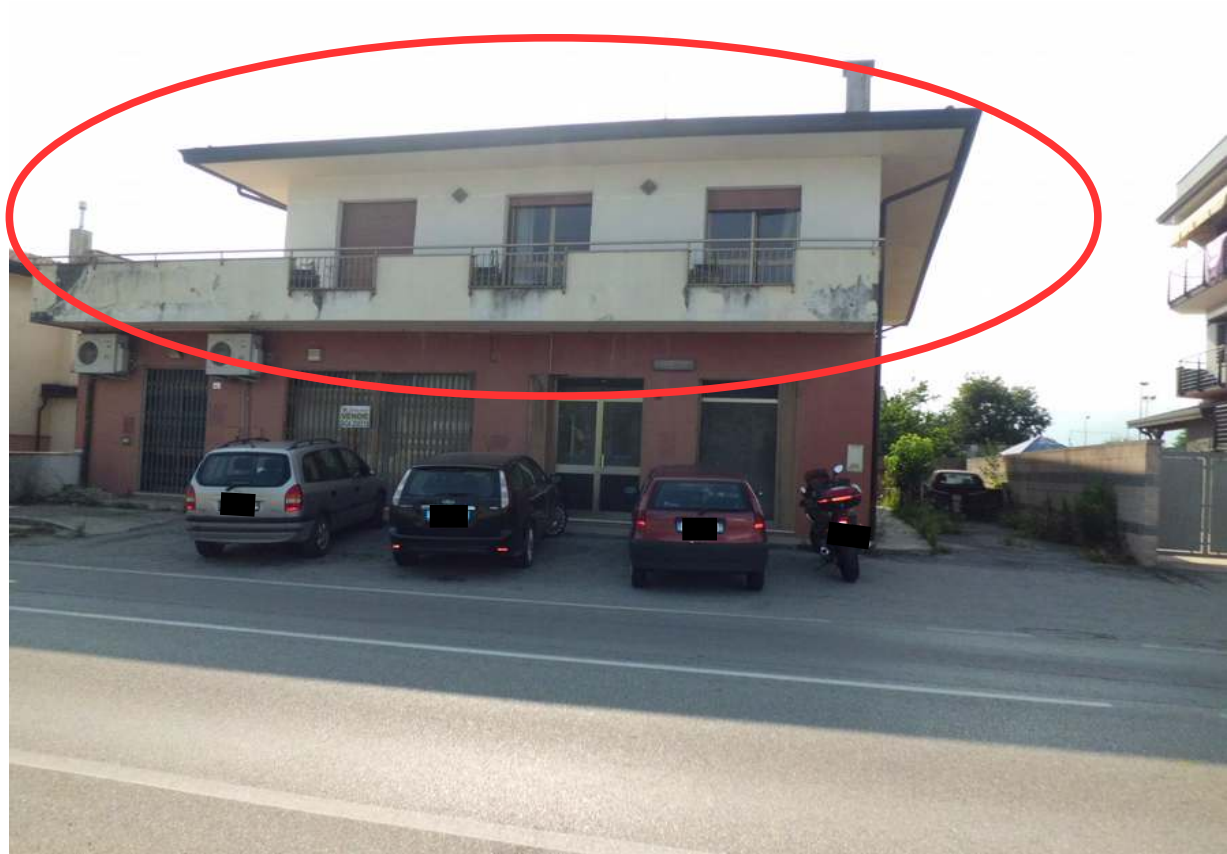
Foto n° 1 - 01/07/2016 - Comune di San Quirino, foglio 59, part. 57 - Veduta generale del fabbricato; l'appartamento eseguito è posto al primo piano. Foto scattata dalla strada pubblica Via dei Templari. L'accesso all'appartamento avviene tramite la scala interna che si immette sul cortile visibile a destra dell'edificio.
