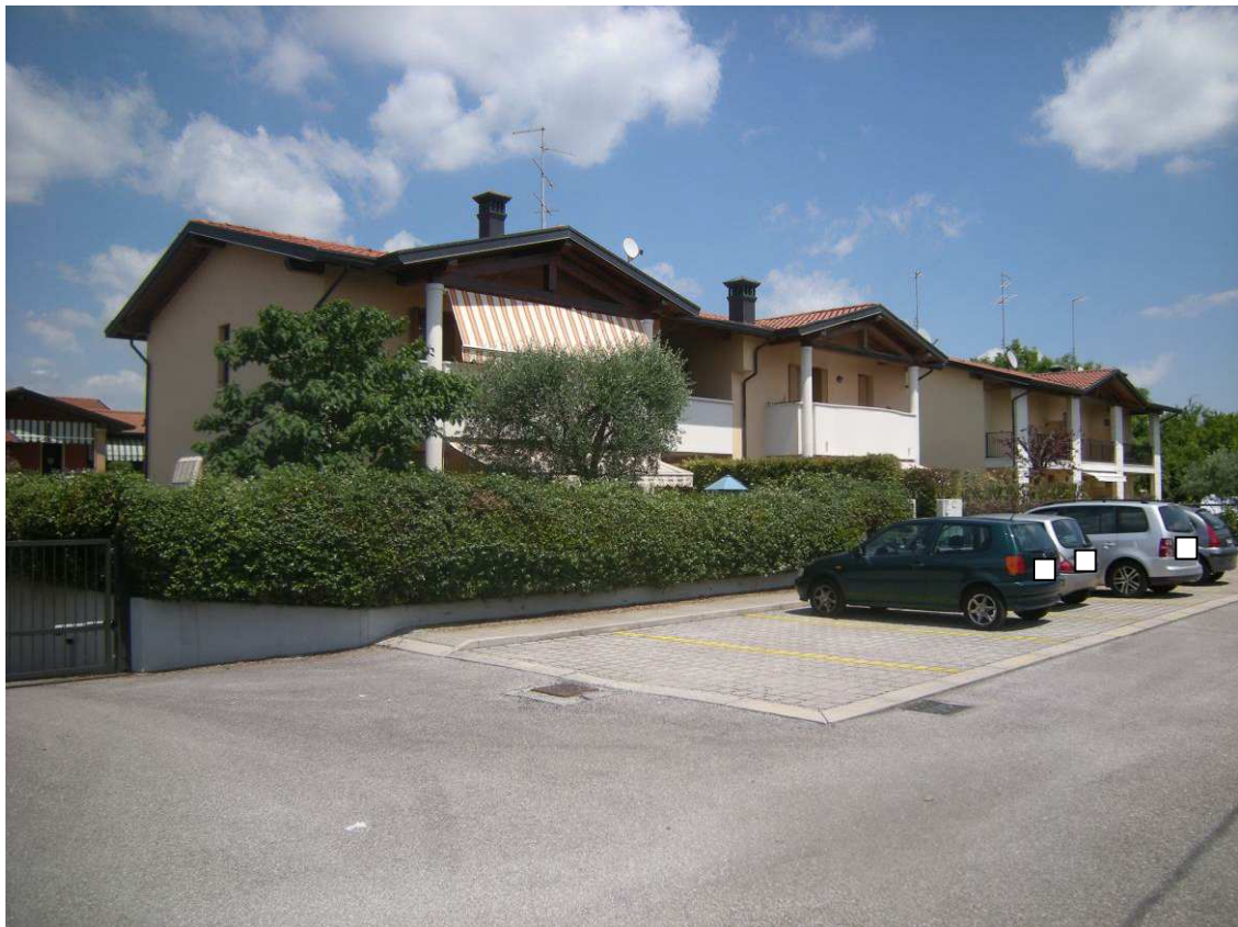
Roveredo in Piano, via I. Nievo 3/H – I posti auto della Palazzina.
