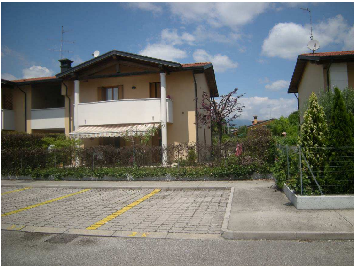
Roveredo in Piano, via I. Nievo 3/H - Il prospetto a sud della palazzina.
