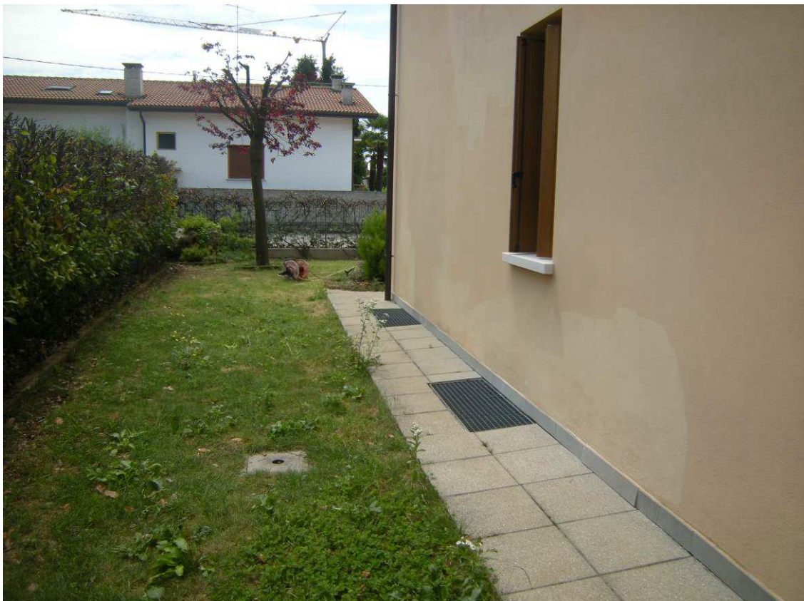
Roveredo in Piano, via I. Nievo 3/H - Il prospetto a est della palazzina.
