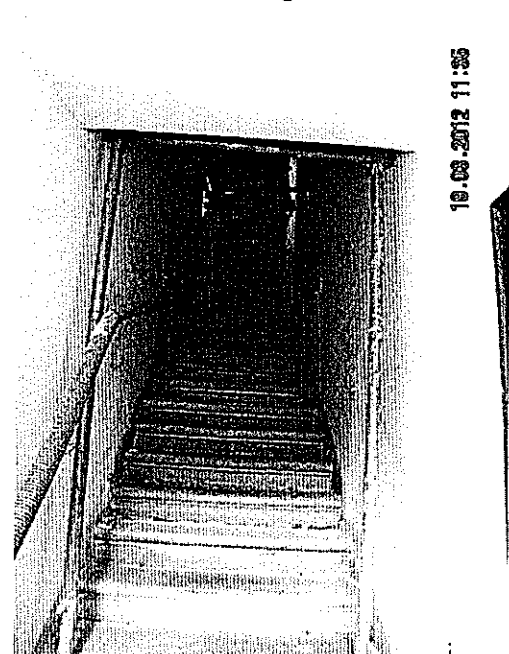
Foto n°36: Androne- Vista scale quadro elettrico e cablaggio
