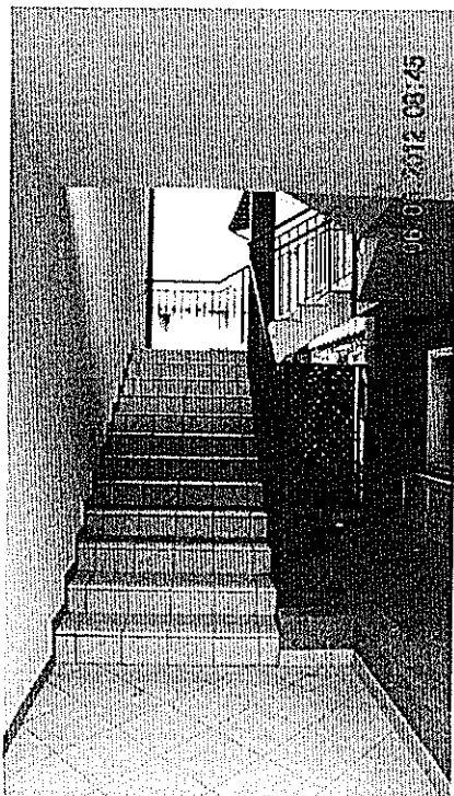
Scale accesso al primo piano.
