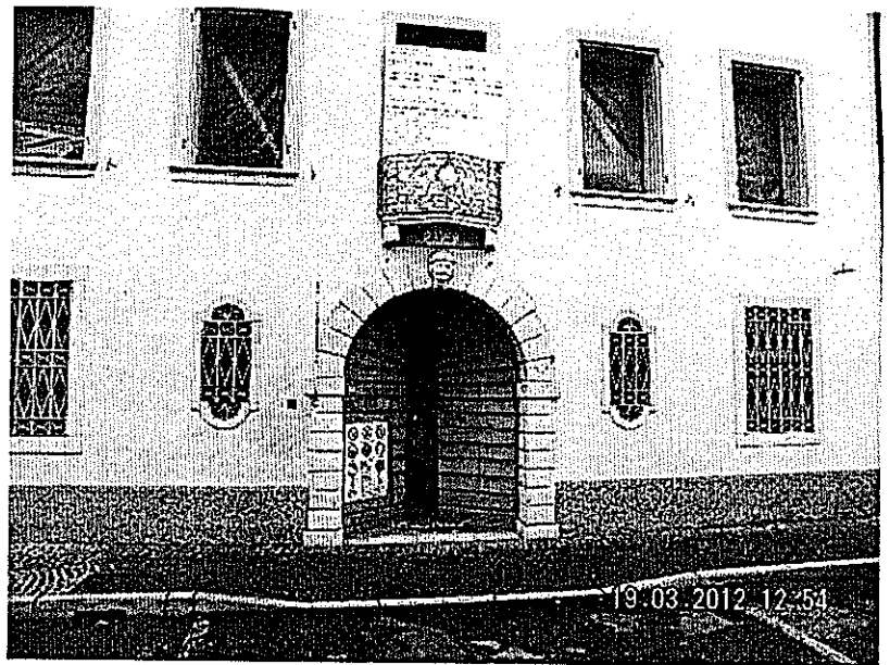
Foto n°2: Facciata fonte strada, particolare portone
