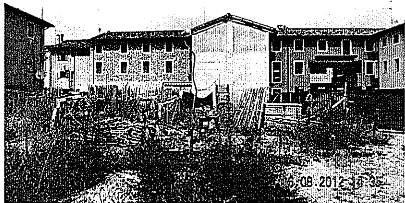
Vista dell'area (lato est), con l'edificio Blocco immobiliare "2B" di collegamento, su progetto esistente.
