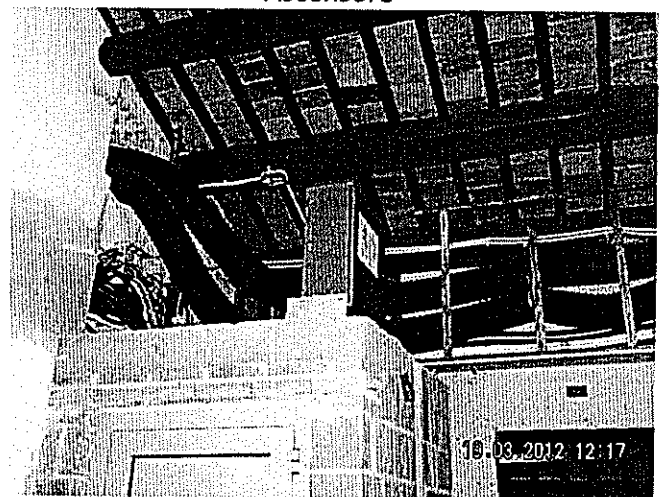
Foto n°77b: Secondo piano: Ballatoio scale- Vista tetto e impianti meccanici posati
