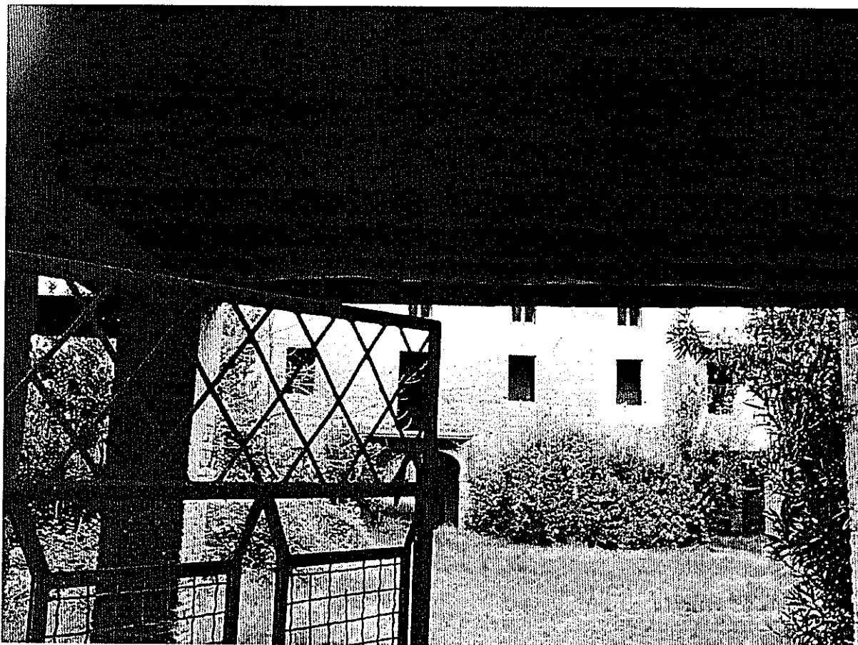
Vista corte interna e fabbricato "B"
