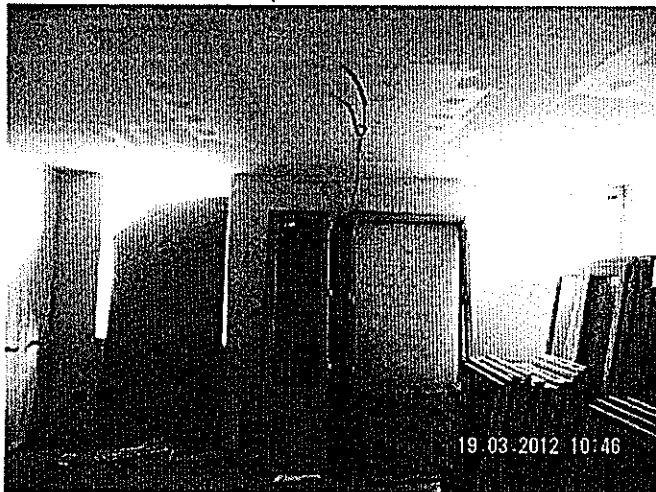
Foto n°25: Stanza 6- Parete lato strada
