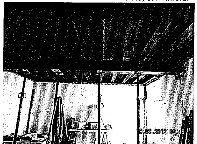
Foto n°9: Stanza n°2- Particolare solaio con trave di rinforzo
