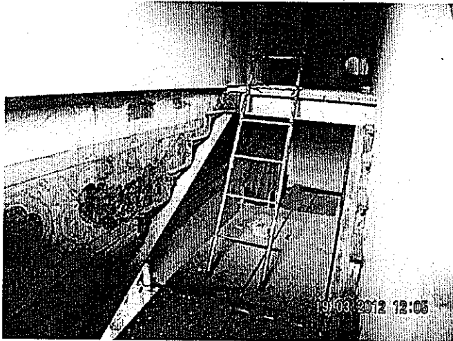
Foto n°75: Scala accesso secondo piano
