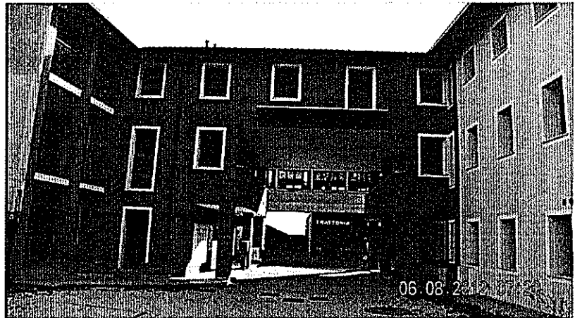
Portico di accesso area, lato interno, con passo pedonali da ambo i lati.
