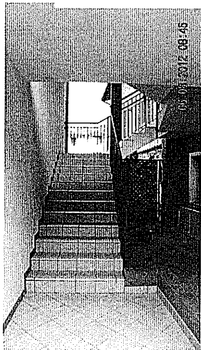
Scale accesso al primo piano.
