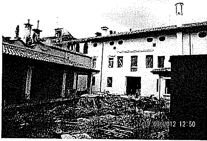
Foto n°95: Vista retro edificio con corte interna
