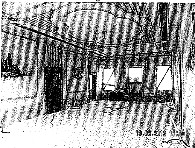
Foto n°50: Stanza 1.5 (sala)- Vista interna parete .lato strada.
