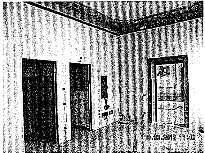
Foto n°40: Stanza 1.1- Vista parete interna e porta sala (stanza 1.4)
