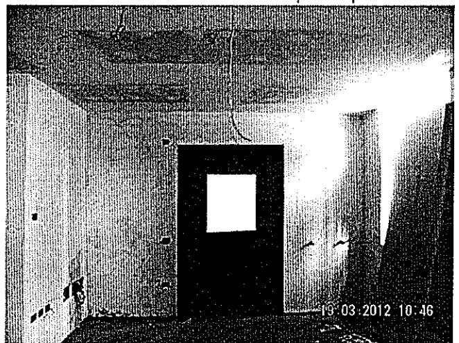
Foto n°24: Stanza 6- Vista interna porta
