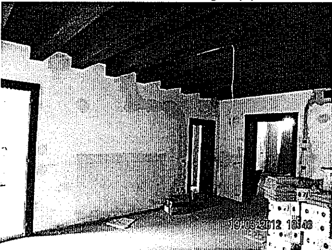
Foto n°30: Stanza 8- Vista parete lato androne e porte accesso.
