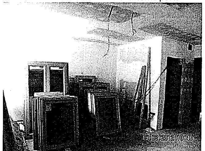
Foto n°26: Stanza 6- Vista parete interna porta bagno
