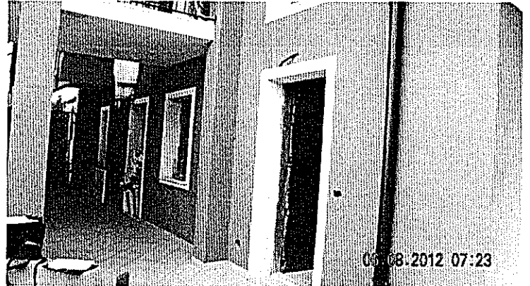
Area di pertinenza lato interno
