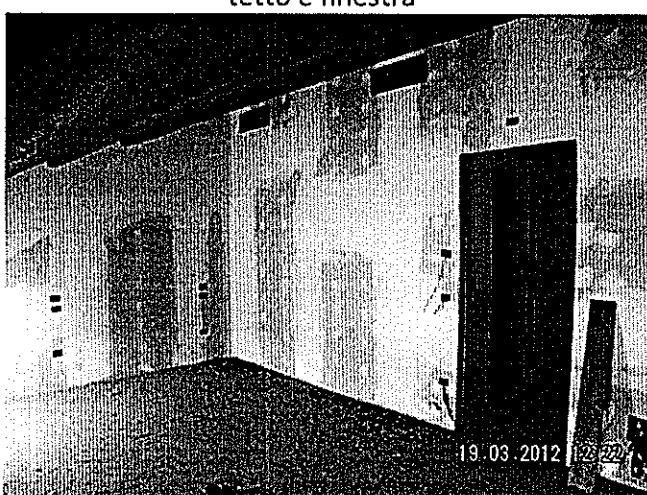
Foto n°90: Stanza 2.6: Vista parete interna con porta accesso.
