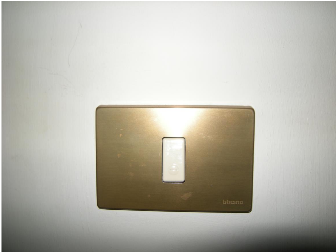
Azzano Decimo, Piazza G. Garibaldi n. 28/5 – L'interruttore generale dell'impianto elettrico dell'appartamento ed il comando luce.
