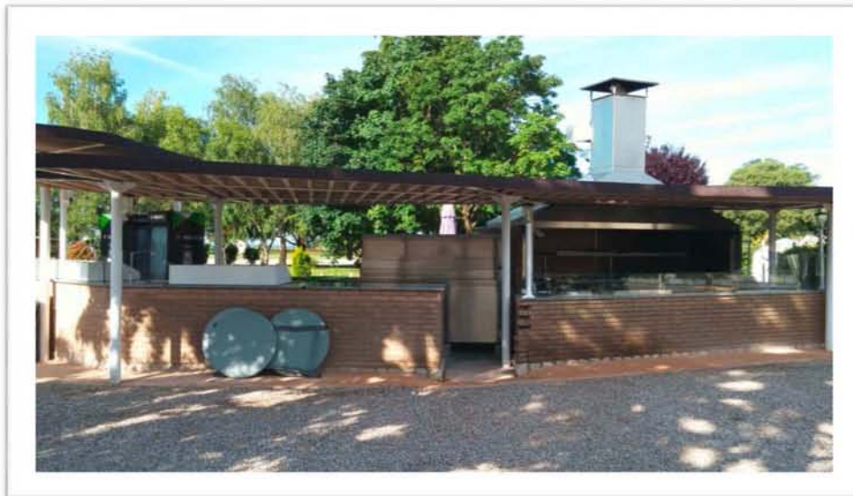
AREA ESTERNA TETTOIA BARBECUE
