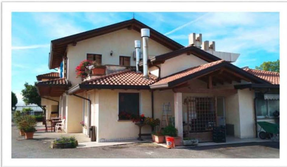
FABBRICATO PROSPETTO LATERALE
