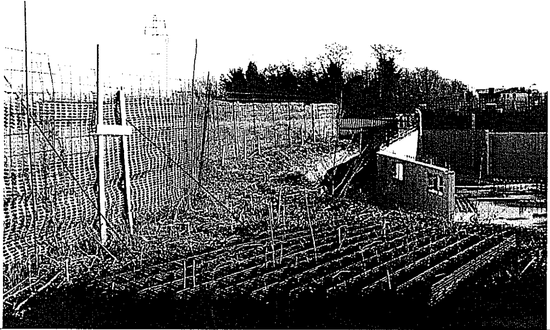
vista dell'area in costruzione blocco E
