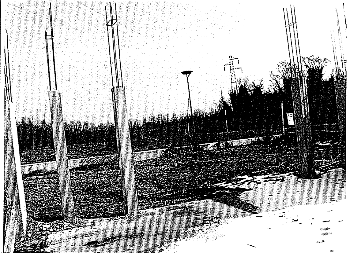
vista del piano terra blocco D
