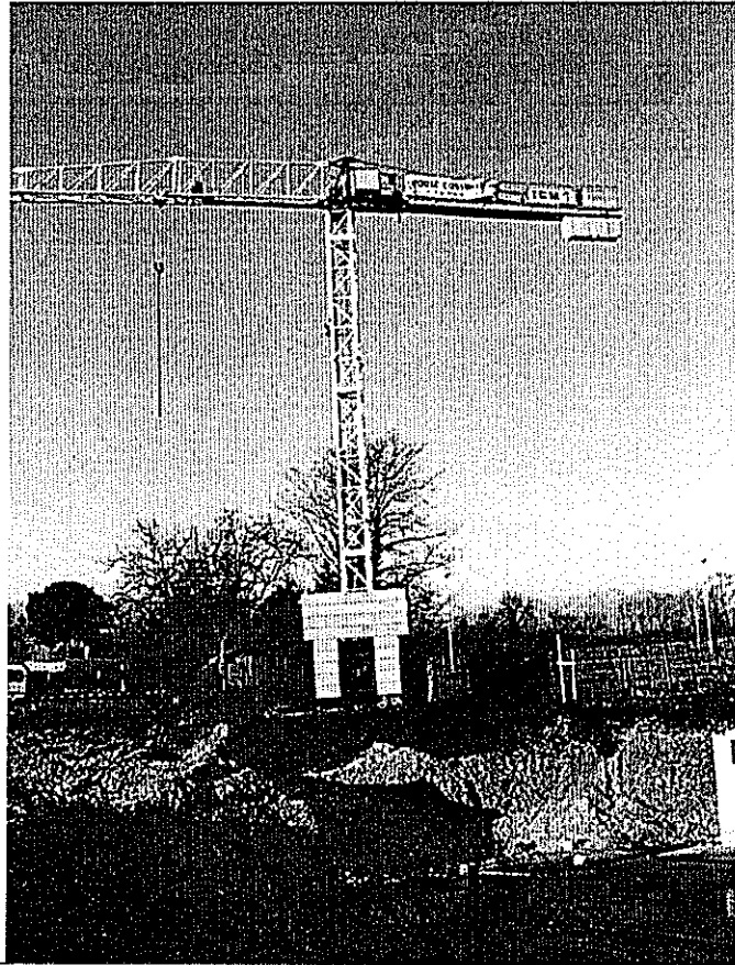
vista dell'area in costruzione blocco E
