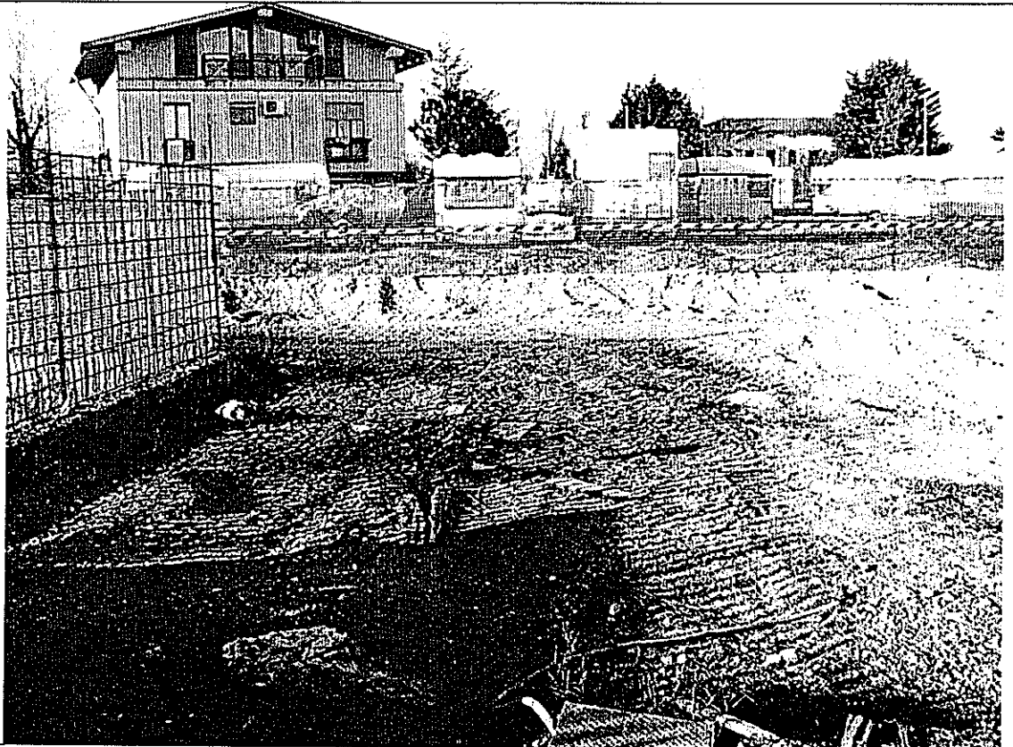
vista dell'area in costruzione blocco E
