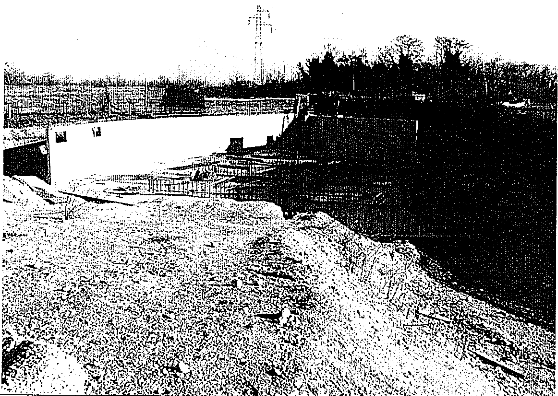
vista dell'area in costruzione blocco E
