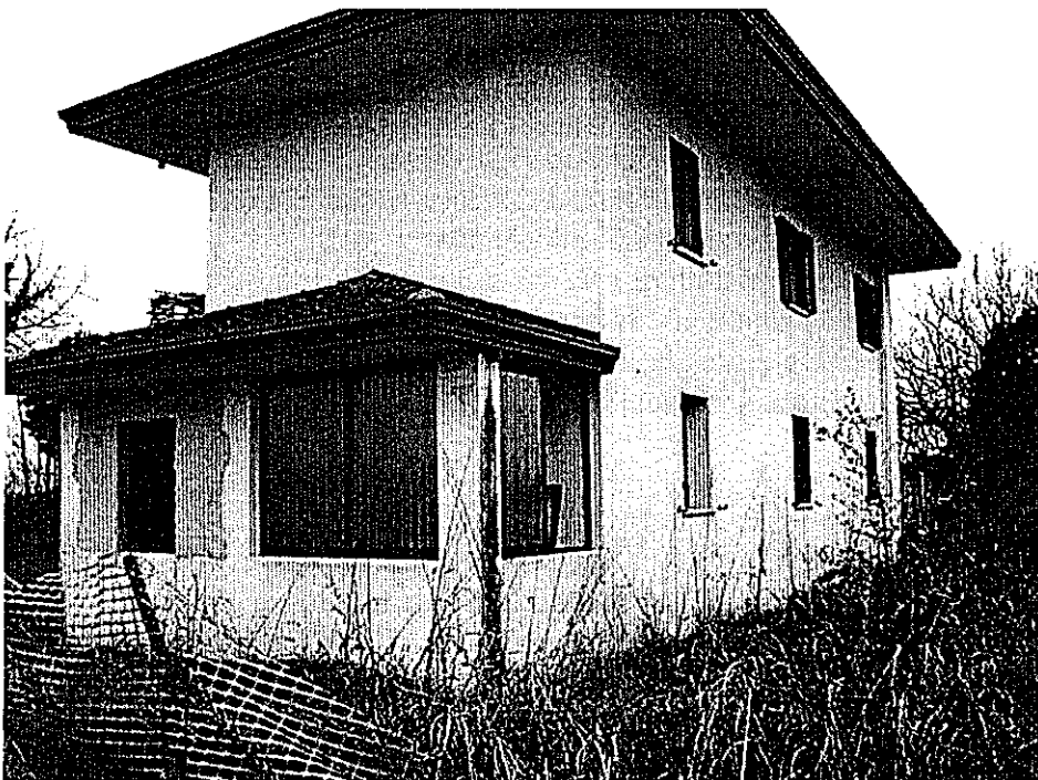
fotografia del retro dell'immobile (fg.50 mappale 403)
