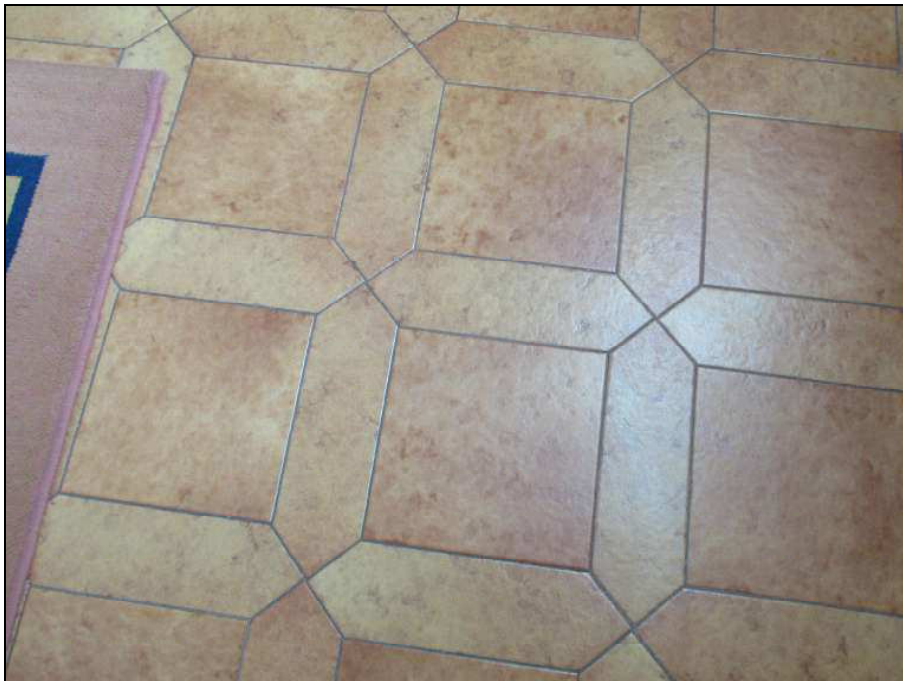
Fig.15: particolare pavimentazione soggiorno, cucina e disimpegno notte
