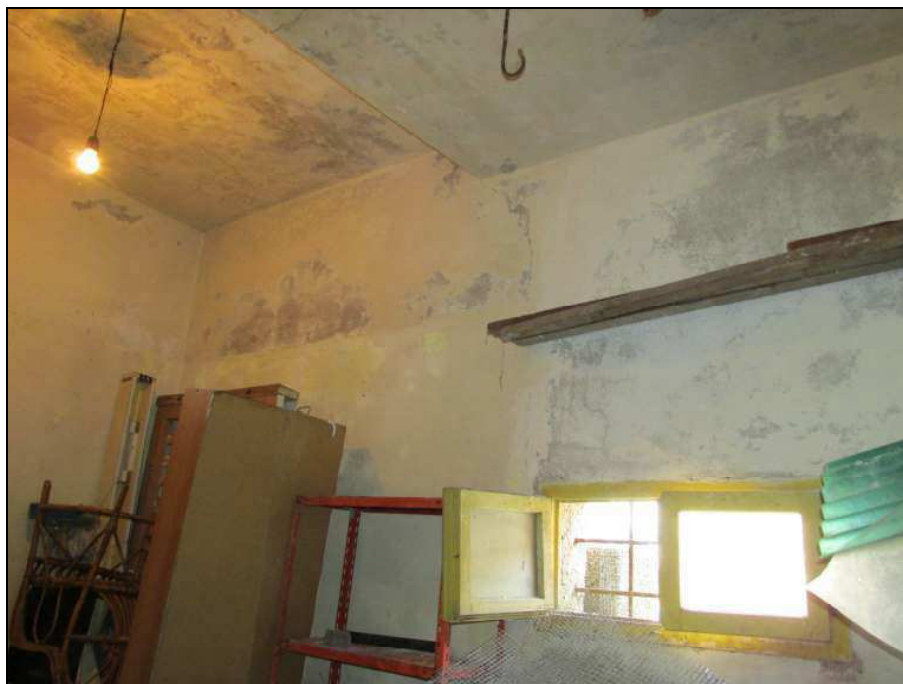
Fig.25: vista interni della cantina ad uso comune
