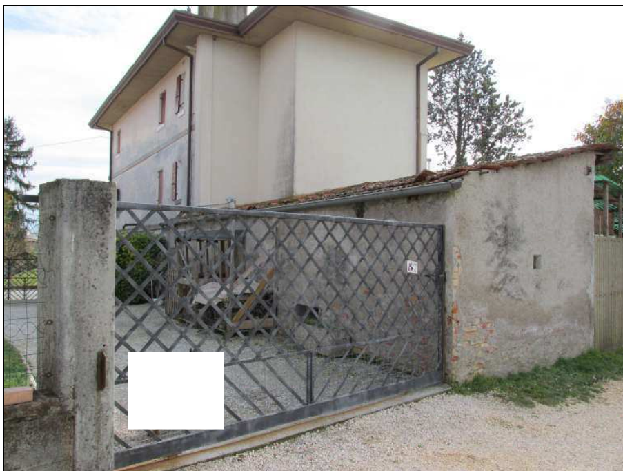
Fig.6: vista lati nord ed ovest del portico e della cantina
