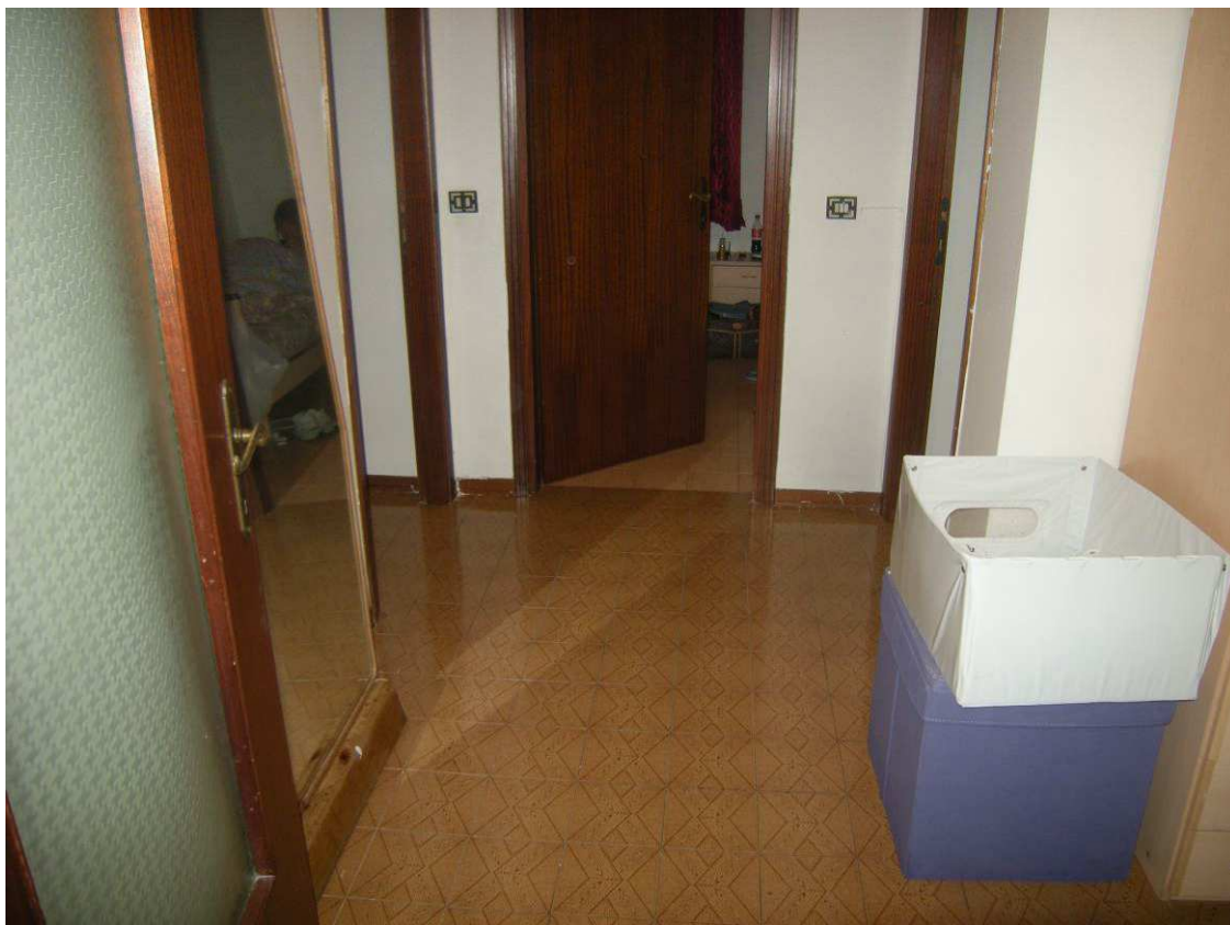
Aviano, Via B. Buozi 5 – Sopra l'atrio, sotto il disimpegno.
