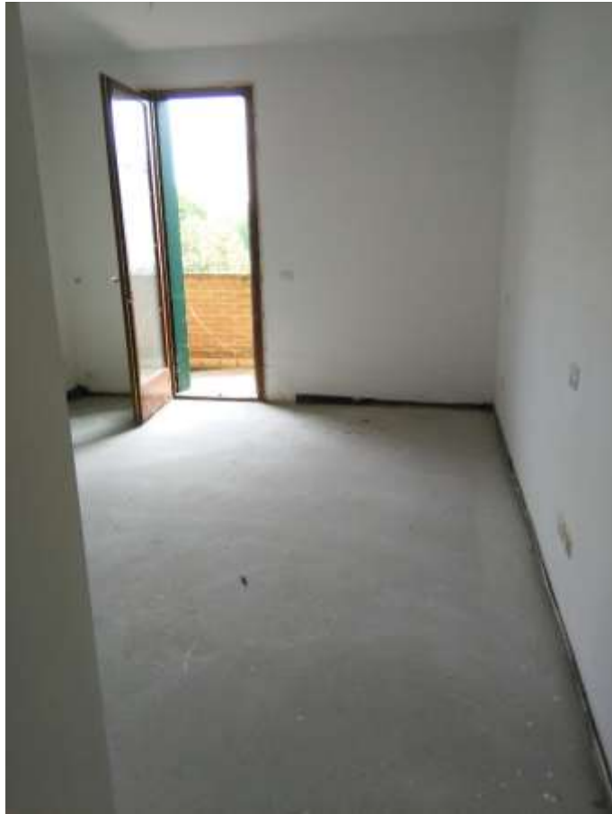
FOTO 15_PIANO PRIMO_CAMERA 2 LETTI AD EST
