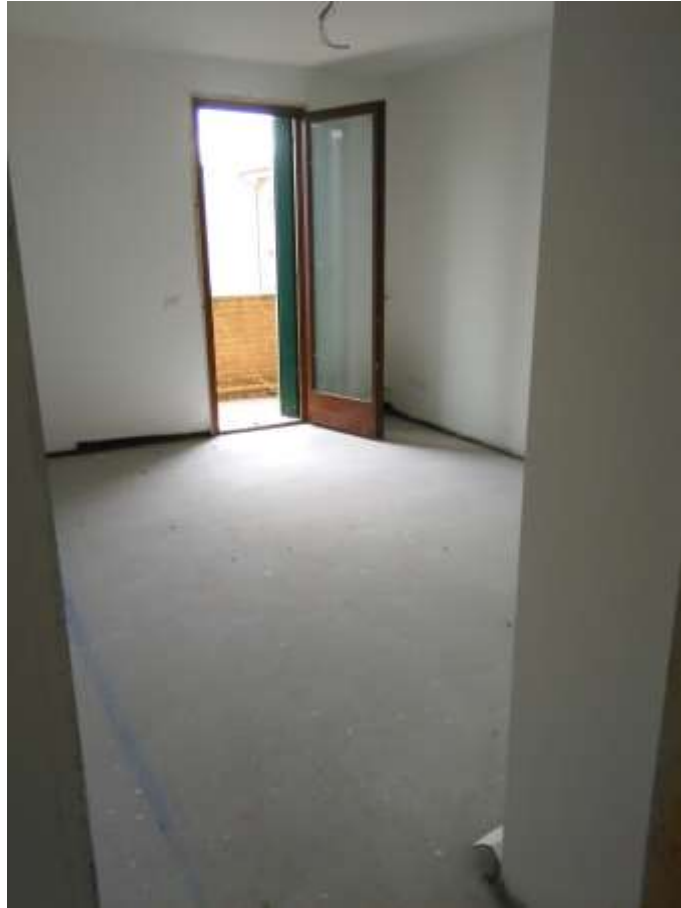
FOTO 13_PIANO PRIMO_CAMERA 2 LETTI AD EST
