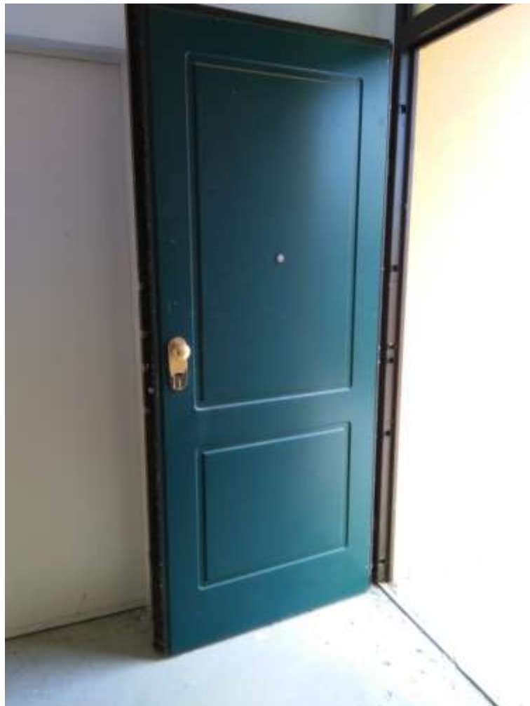
FOTO 6_PARTICOLARE PORTONCINO DI INGRESSO BLINDATO
