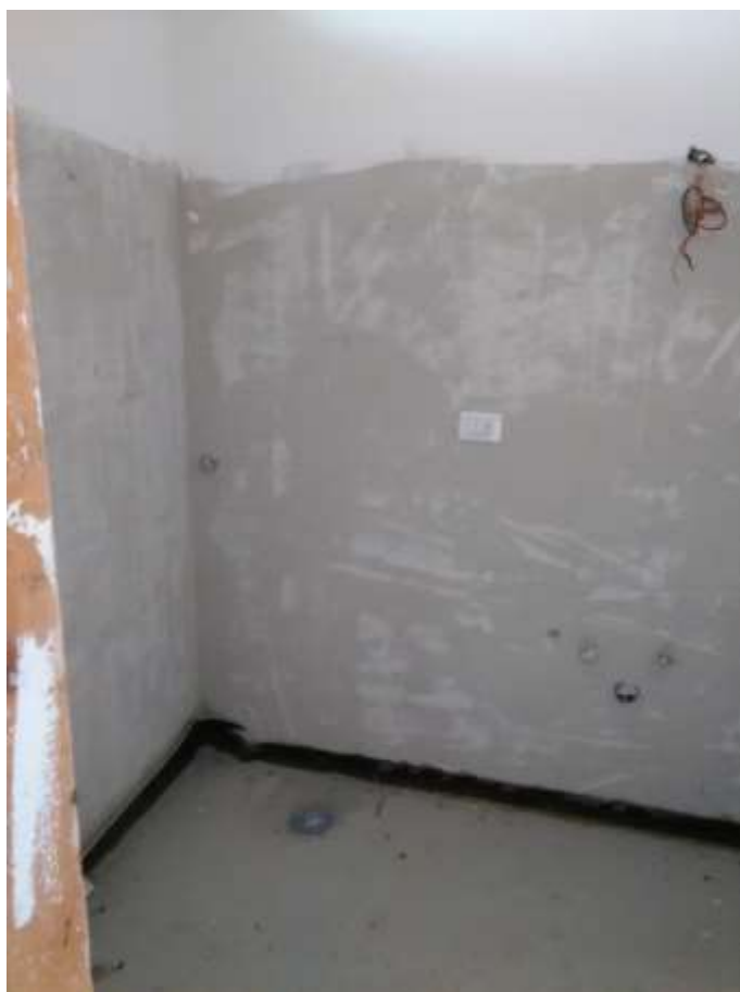
FOTO 11_WC LAVANDERIA AL PIANO TERRA
