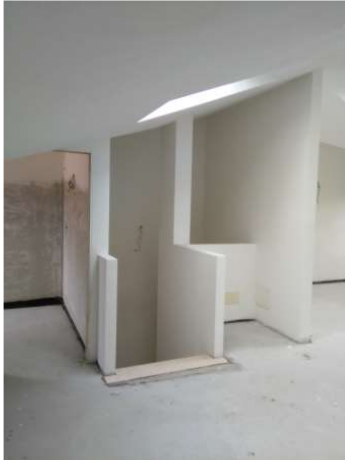
FOTO 19_SOFFITTA_PARTICOLARE ZONA DI ARRIVO SCALE
