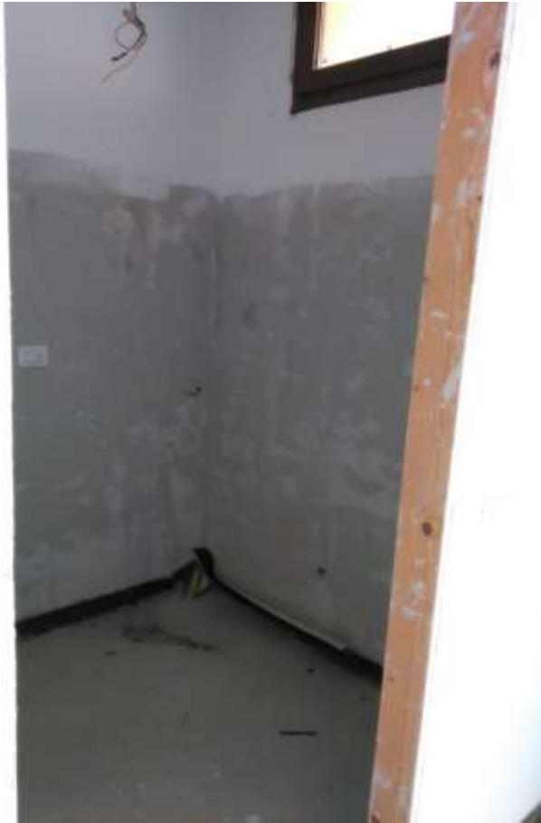
FOTO 11_WC LAVANDERIA AL PIANO TERRA
