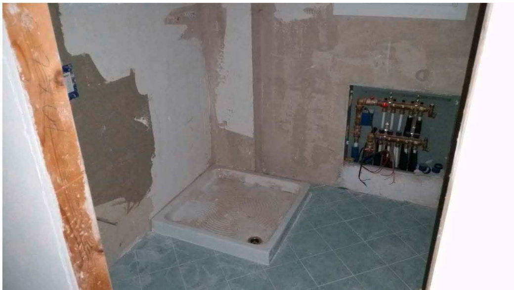
Foto n.18: Bagno al Piano Terra (Mapp.1131)
