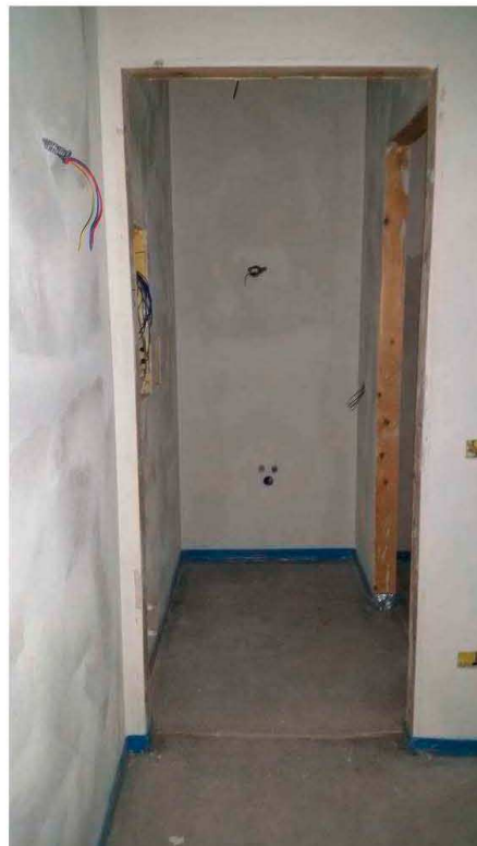
Foto n.26: Disimpegno al Piano Terra ( Mapp.1127 )
