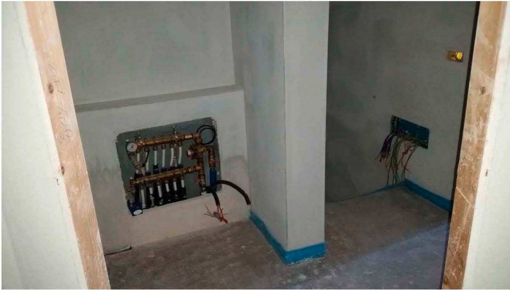
Foto n.29: Disimpegno al Piano Primo (Mapp.1127).
