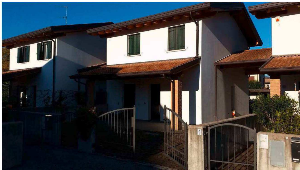
Foto n.23: Prospetto Ovest della villetta a schiera ( Mapp.1127 ) oggetto di E.I.
