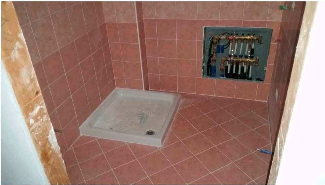
Foto n.9: Bagno al Piano Terra ( Mapp.1132 )
