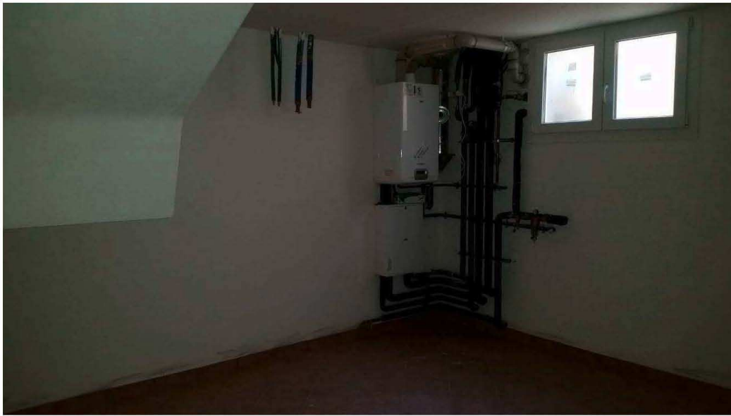
Foto n.11: Cantina al Piano Interrato ( Mapp.1132 )
