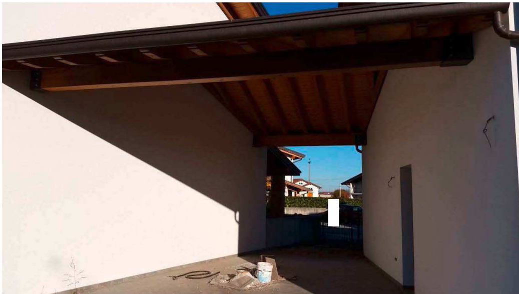
Foto n.7: Portico ad uso posto auto coperto della villetta a schiera (Mapp.1132) oggetto di E.I.
