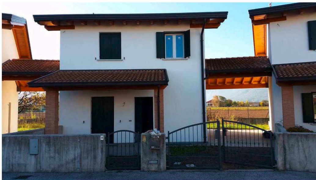
Foto n.15: Prospetto Sud-Est della villetta a schiera ( Mapp.1131 ) oggetto di E.I.
