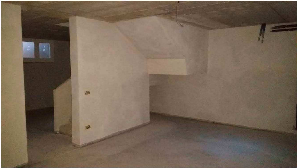
Foto n.27: Cantina al Piano Interrato (Mapp.1127)
