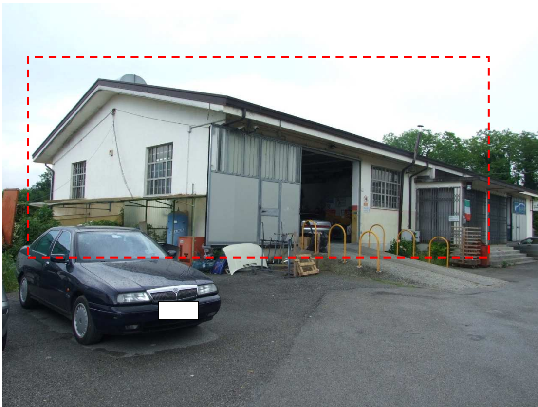
Vista immobile (nel riquadro l'immobile identificato come sub 1)
