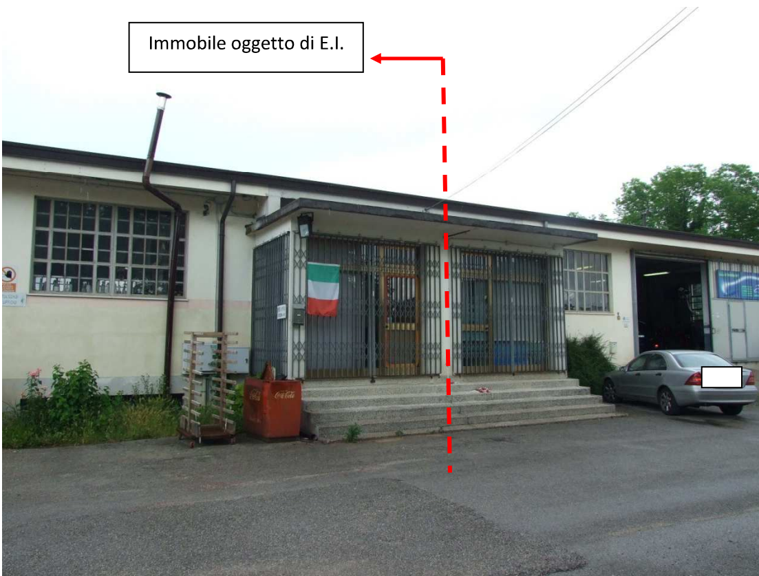
Vista parziale immobile (sub 1)
