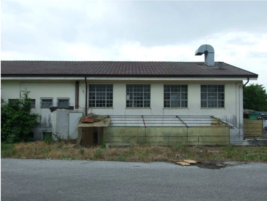
Seconda rampa di accesso all'interrato (sub.2) – vista laterale
