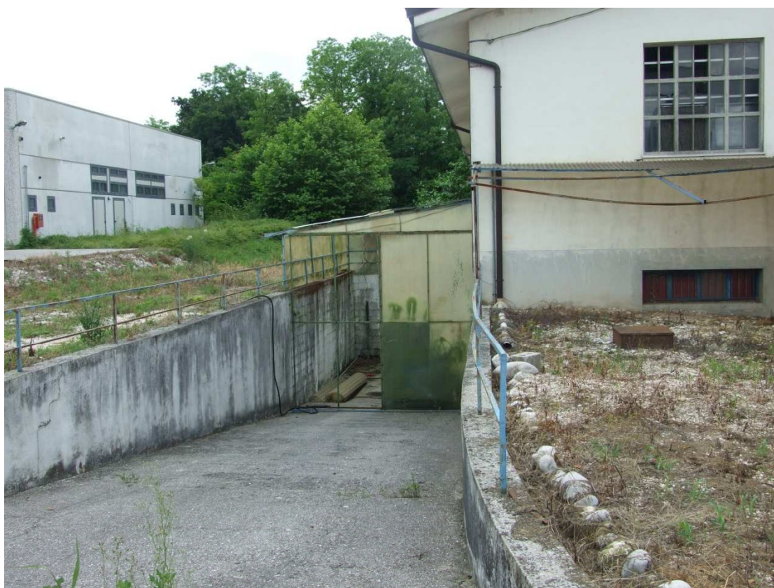
Seconda rampa di accesso all'interrato (sub.2) – vista frontale
