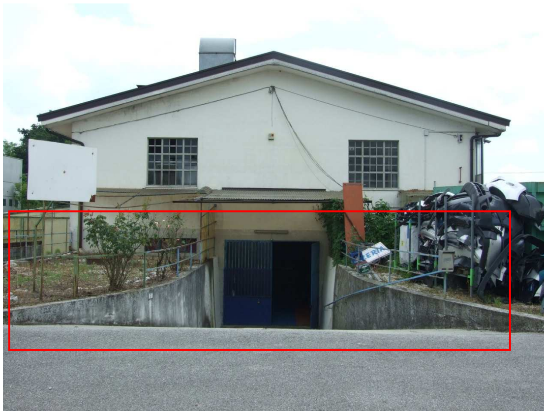
Prima rampa di accesso all'interrato (nel riquadro l'immobile identificato come sub.2)
