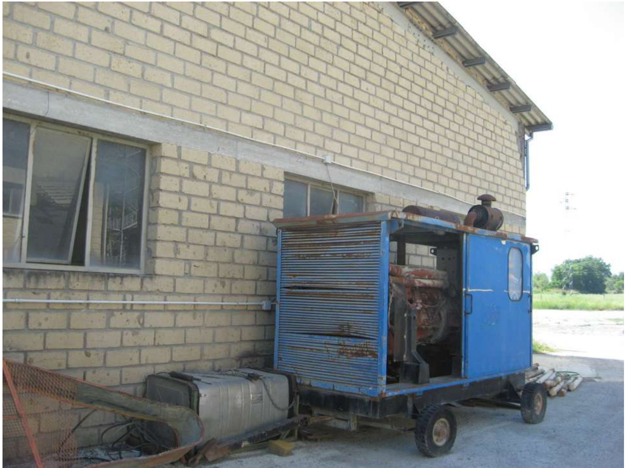
FOTO DEL FIANCO DEL CAPANNONE
