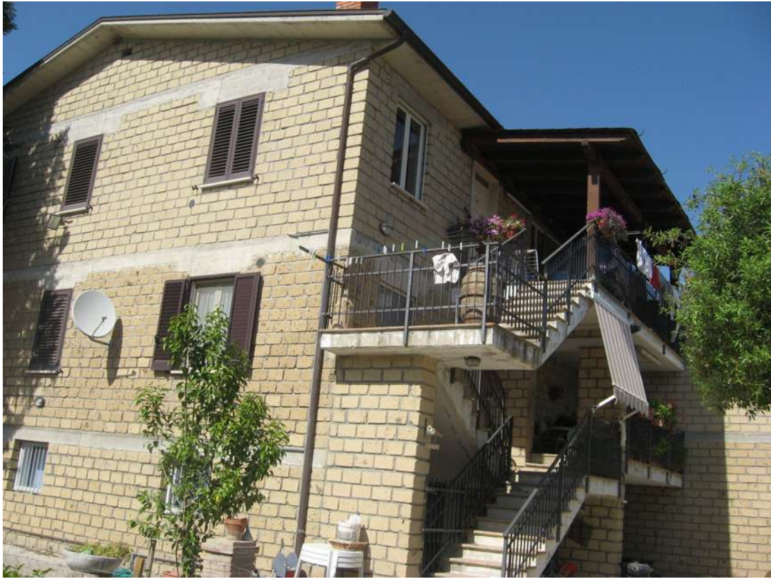
SCALA DI ACCESSO
