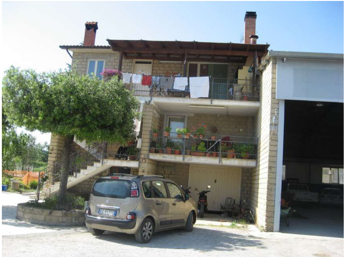
FOTO DEL FRONTE DELLA PALAZZINA
