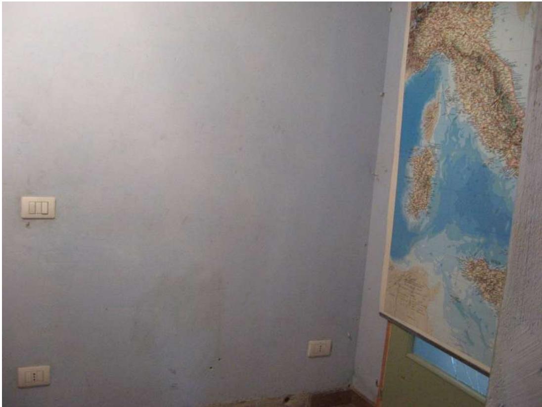
disimpegno del capannone artigianale
