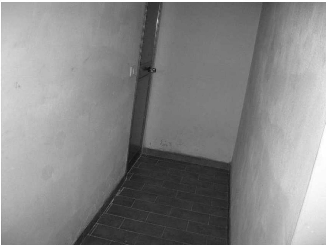
disimpegno del capannone
