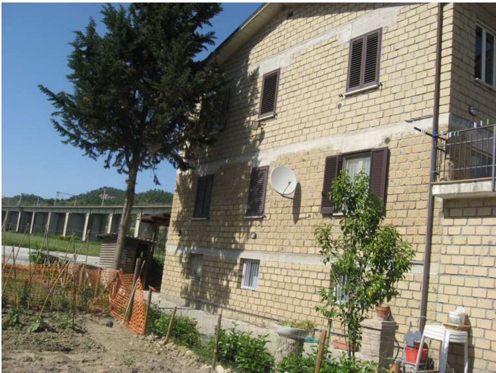
VISTA AL FIANCO DELLA SCALA
