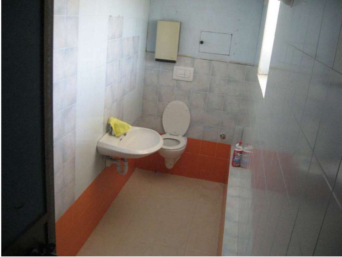
bagno del capannone
