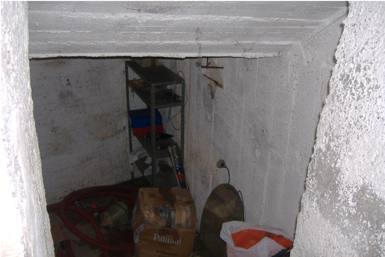
PICCOLO RIPOSTIGLIO INTERRATO
