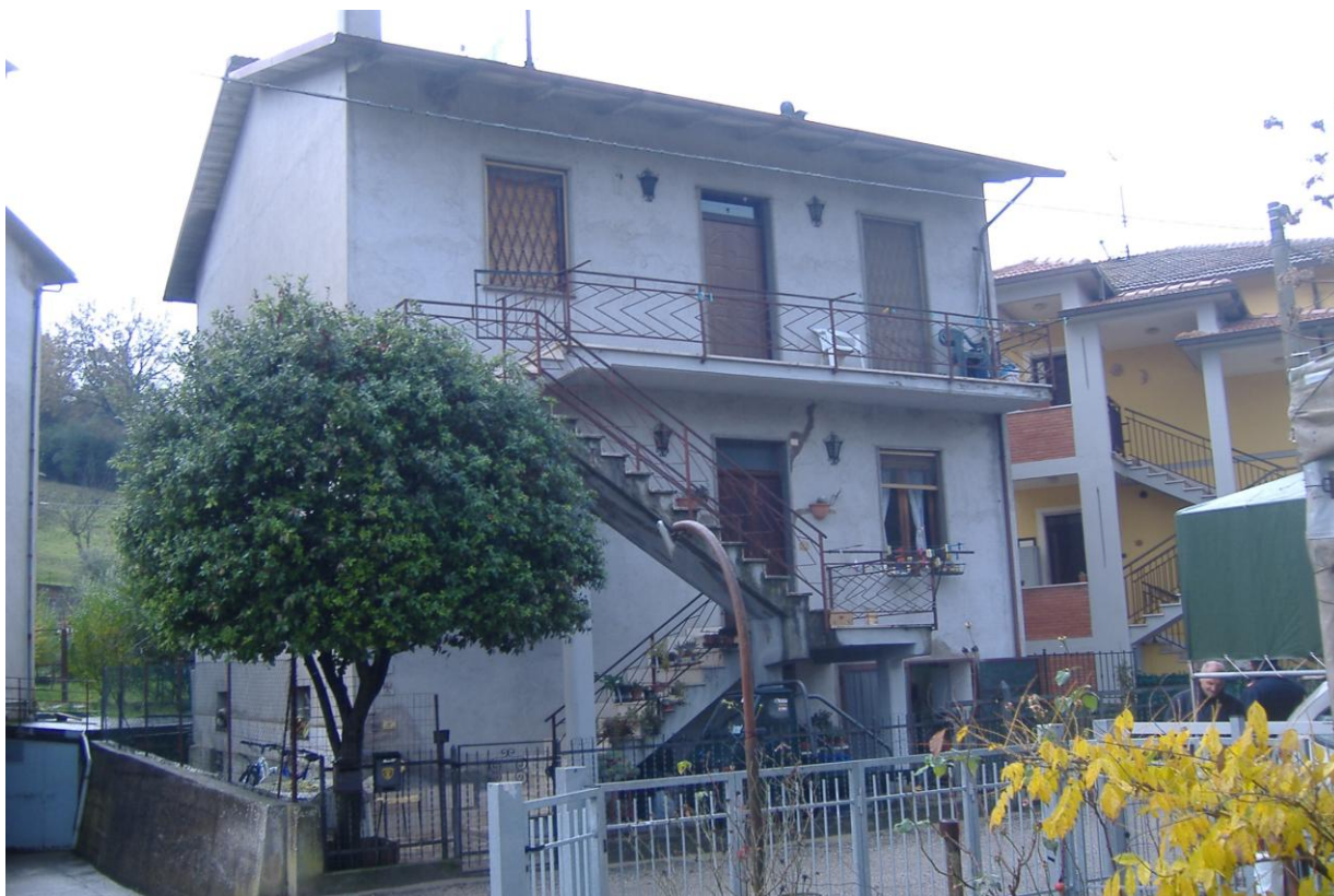
PROSPETTO ANTERIORE SU STRADA DI FIACCHIGNANO Appartamento sub. 3 piano I° catastale
