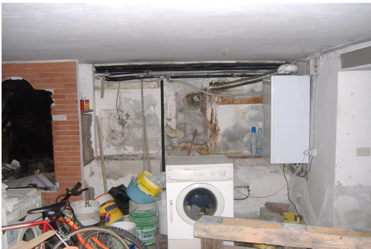
CANTINA LATO DX CON ATTACCO LAVATRICE E CALDAIA Sub. 5
