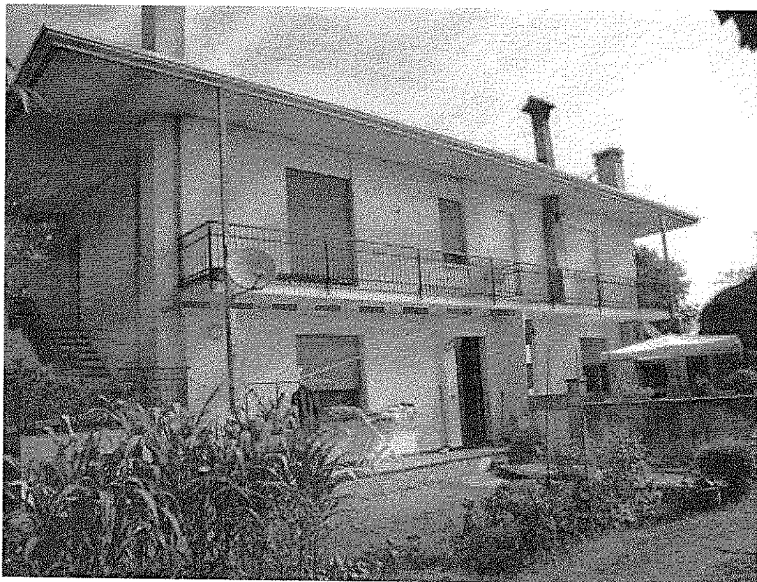
Foto 12 – vista del prospetto sud dell'appartamento al piano terra oggetto di esecuzione (tratteggiato in rosso)
