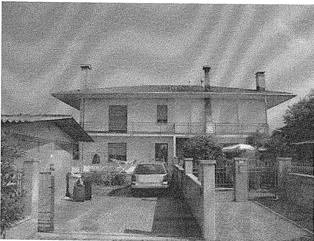
Foto 10 – vista da sud dell'accesso carraio all'immobile
