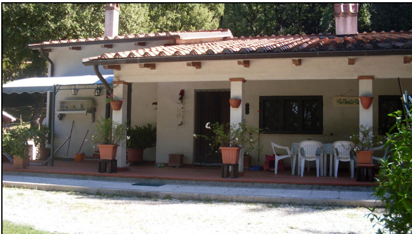
-Veduta prospetto esterno principale –
