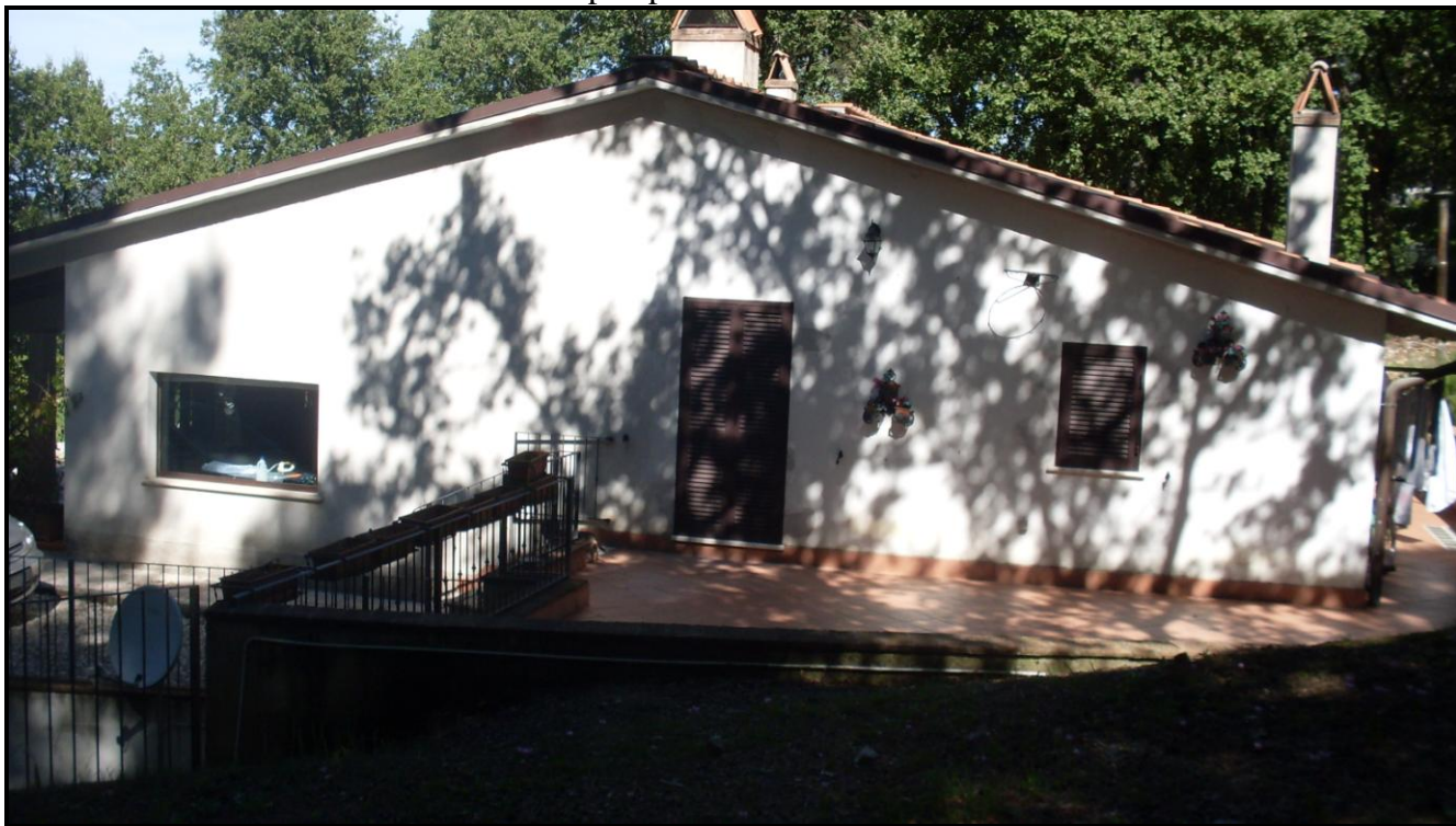
-Veduta prospetto esterno laterale-
