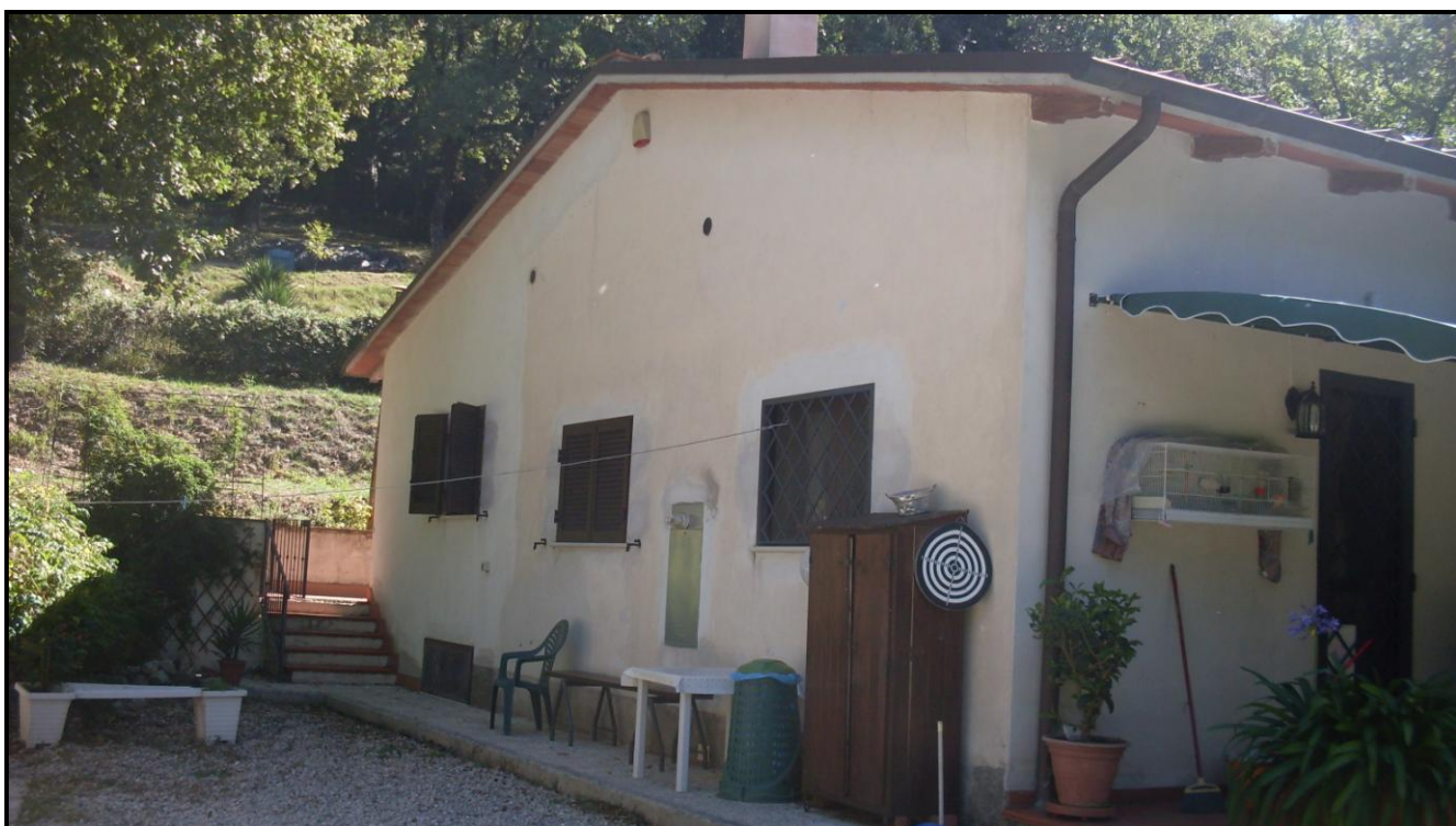
-Veduta prospetto esterno laterale-
