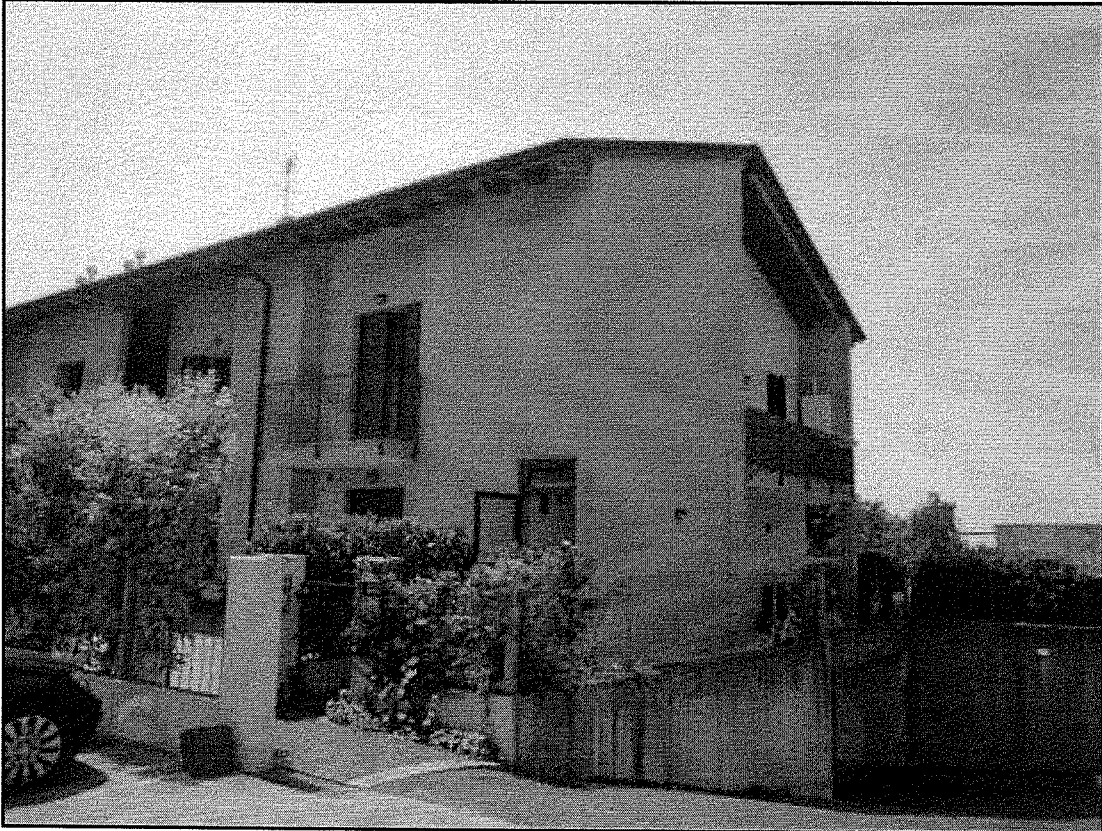
VISTA ESTERNA - LATO NORD
