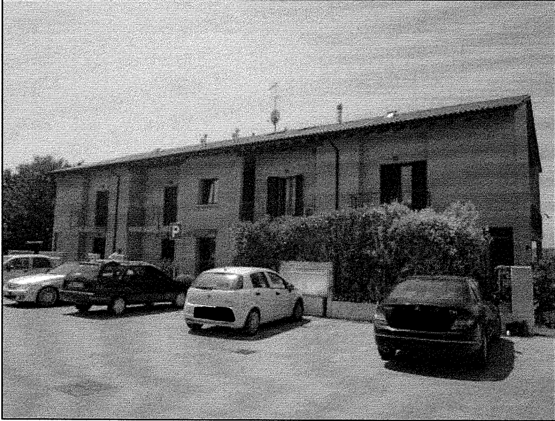
VISTA ESTERNA - LATO EST
