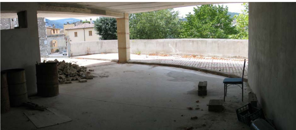
Foglio 97 particella 484 sub.18, 485, 486 e 487: uscita del parcheggio
