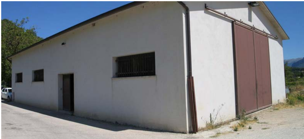
Foglio 98 particella 417: prospetti laterale e posteriore
