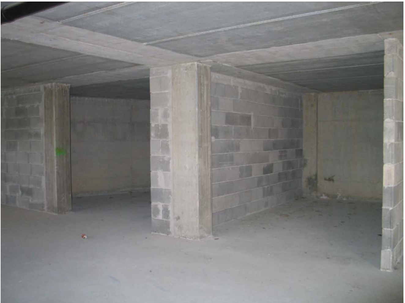
Foglio 97 particella 484 sub.18: tipologia box interno
