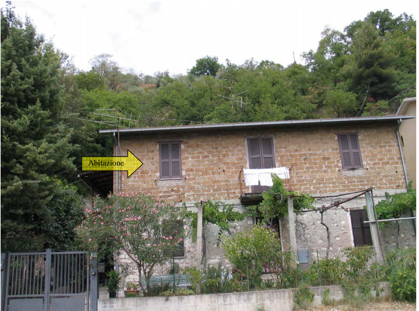
Foglio 98 particella 265 sub.1: appartamento posto al primo piano
