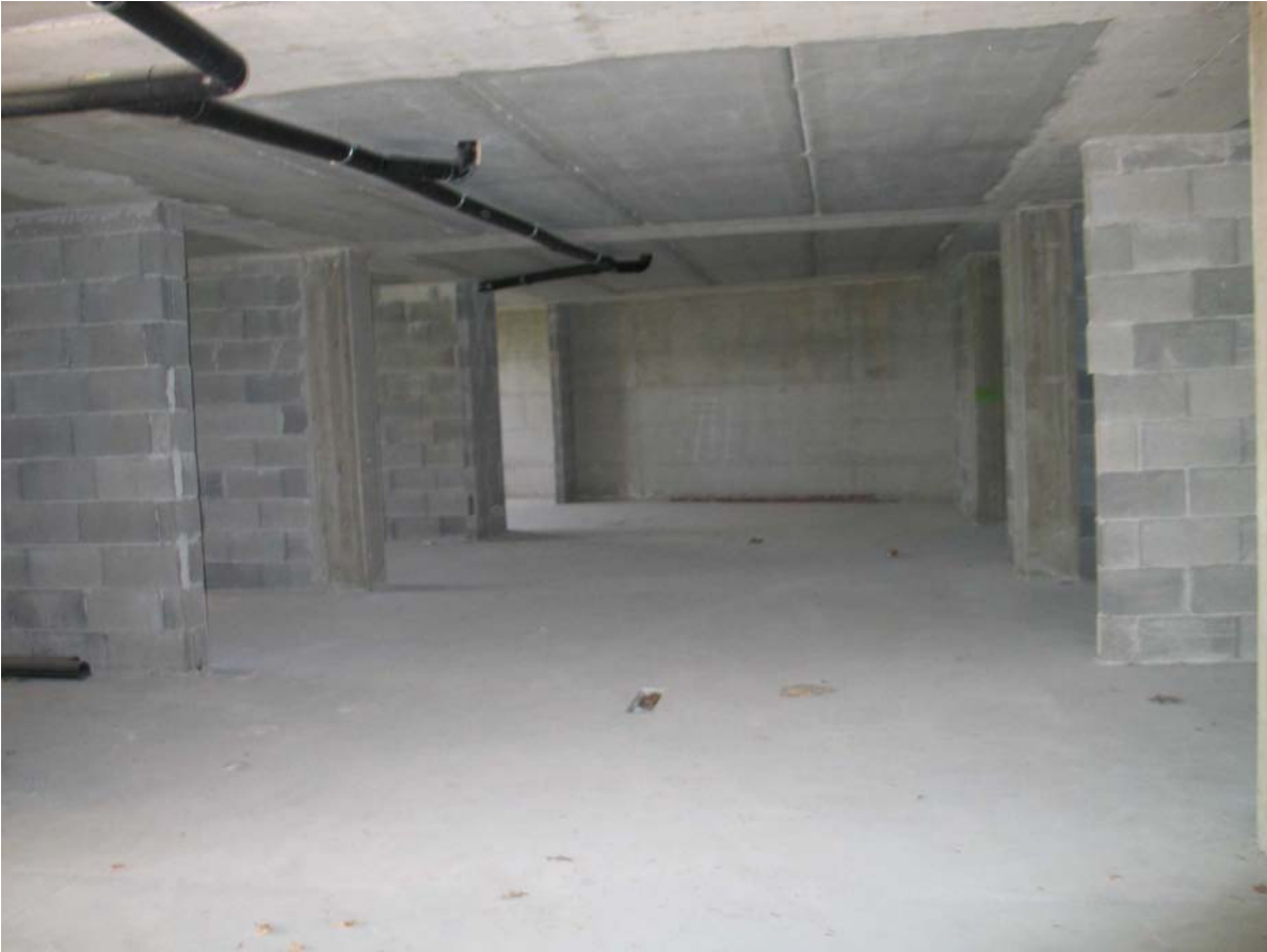
Foglio 97 particella 484 sub.18: panoramica interna
