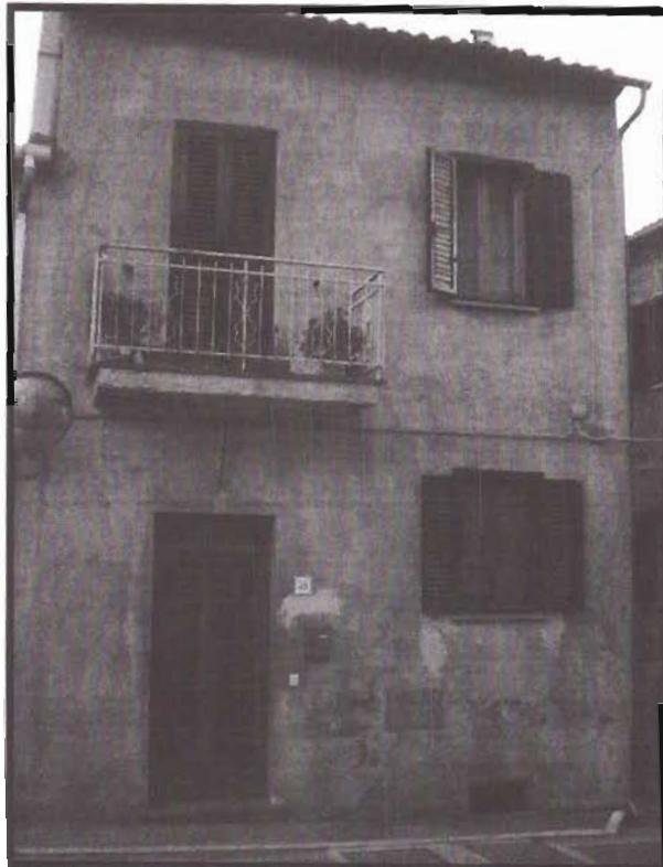
-Veduta esterna immobile oggetto di esecuzione-
