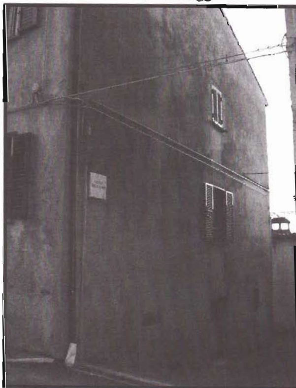
-Veduta esterna laterale immobile oggetto di esecuzione-
