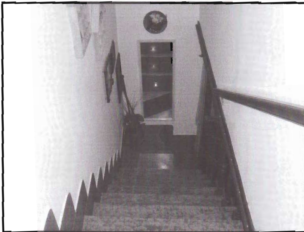
-Veduta interna immobile vano scala-
