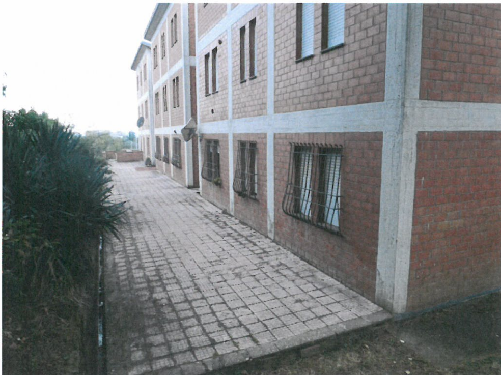
Foto n.8 - Area condominiale sub.1
