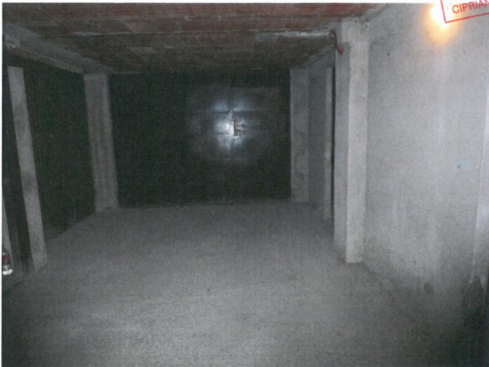
Foto n.4 - Corsello condominiale sub.1
