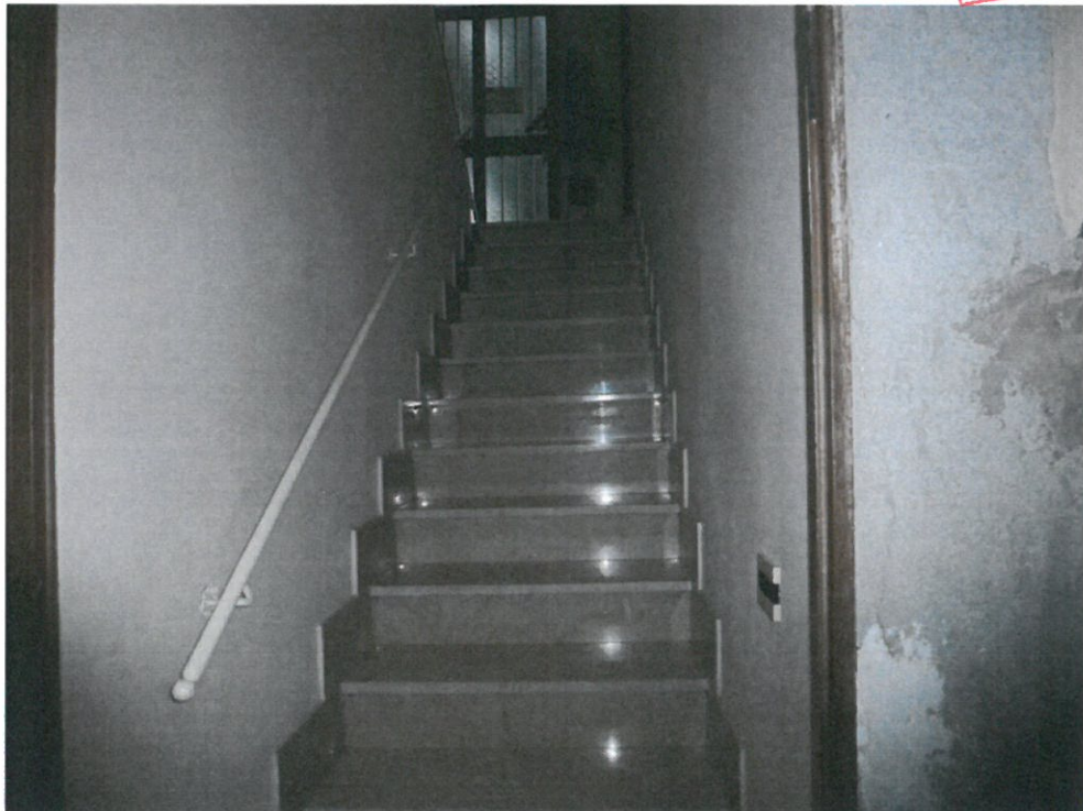
Foto n.2 - Scale condominiali sub.3
