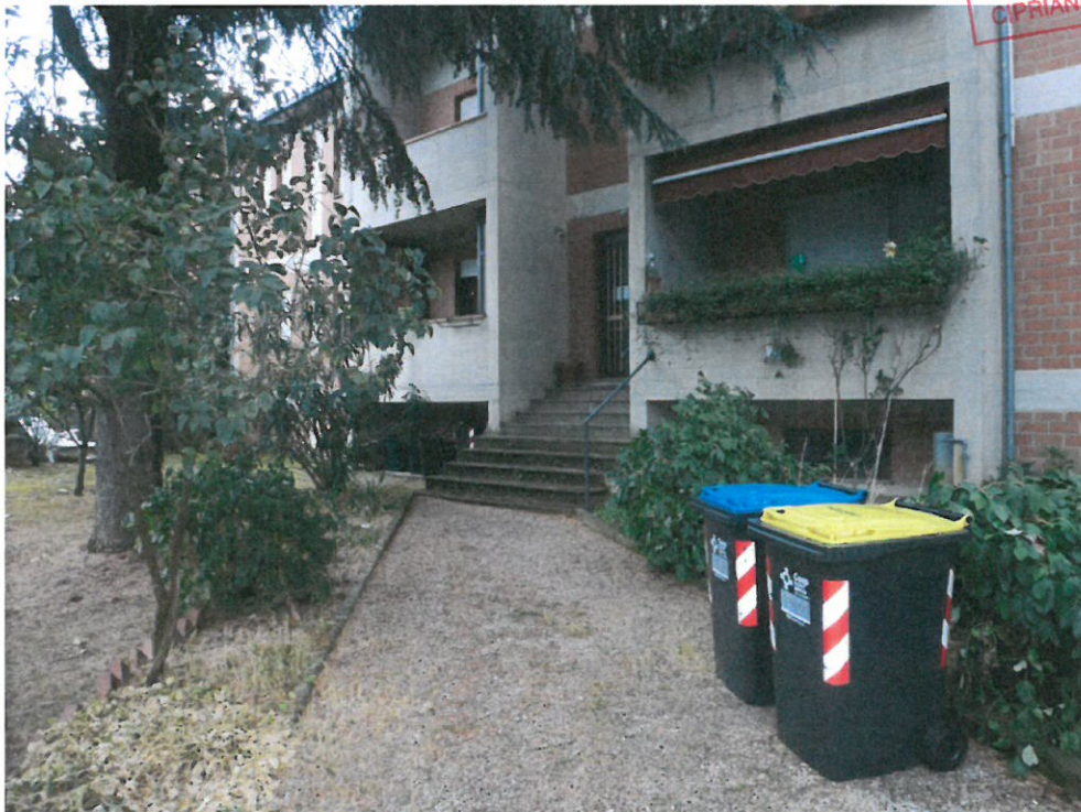
Foto n.6 - Area condominiale sub.1
