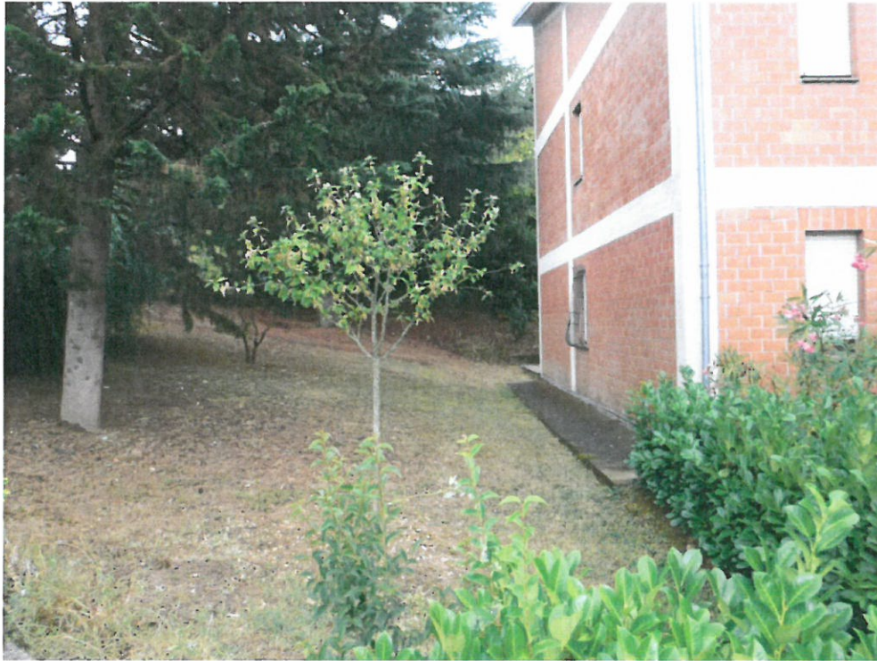
Foto n.7 - Area condominiale sub.1
