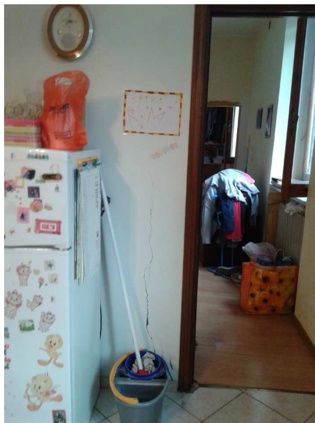
Foto 20: Ingresso alla camera con pavimento in legno
