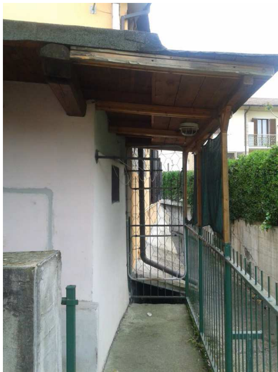
Foto 4: Tettoia sul retro del ripostiglio
