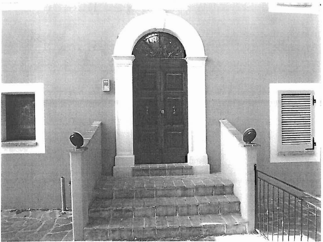
Foto n.1 ingresso al Sub.14
