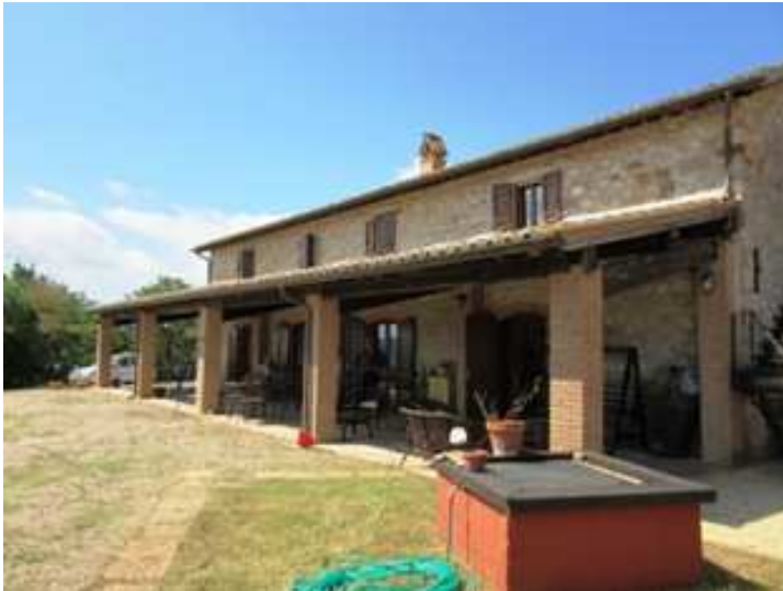
(fabb.to principale, lato Sud-Est)
