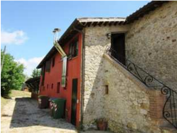
(fabbr.to principale, lato Sud-Ovest)
