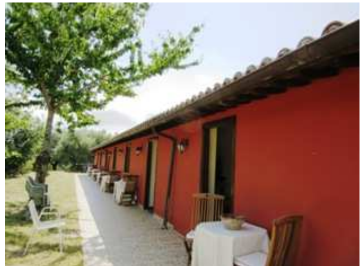
(corpo in ampliamento lato Nord)
