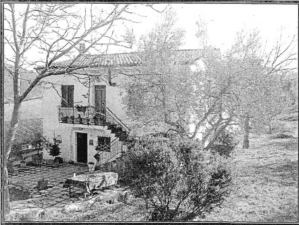
Fabbricato 2 porz. 2 – Esterno
