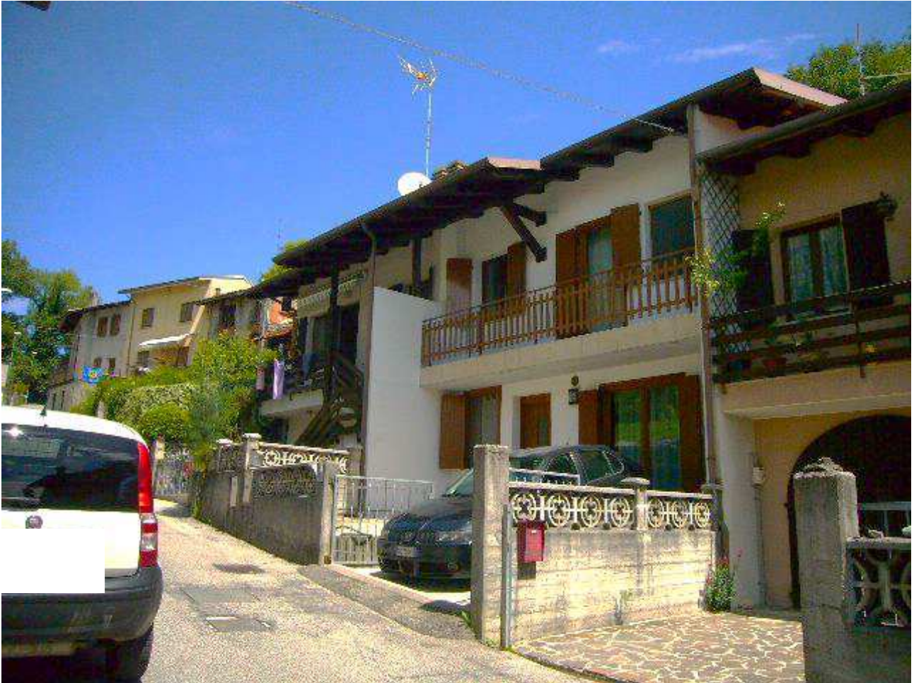
ESTERNO FRONTE STRADA
