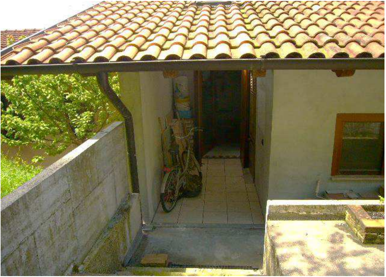
ESTERNO LATO EST PIANO PRIMO
