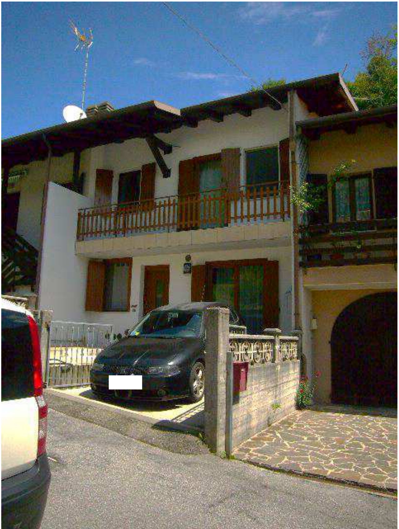
ESTERNO FRONTE STRADA
