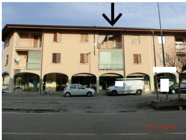
particolare prospetto ovest del fabbricato -prospetto principale-
