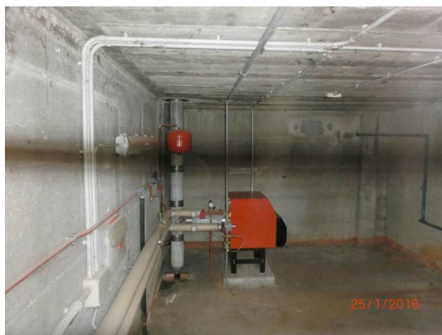
particolare ex centrale termica comune
