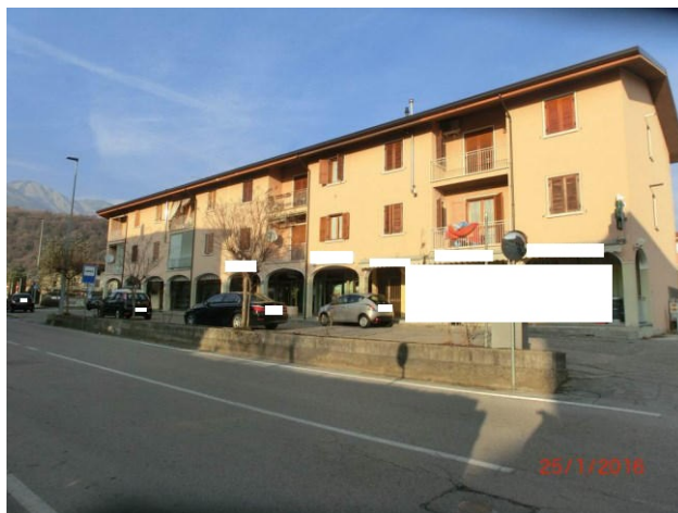
prospetto ovest del fabbricato
