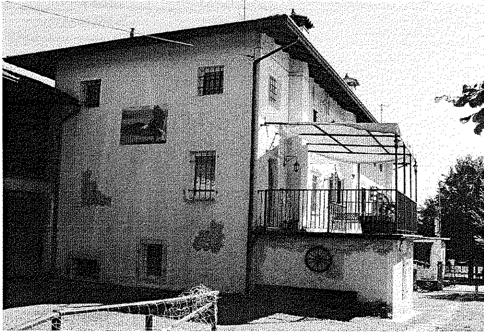
VISTA DALLA STRADA DI ACCESSO
