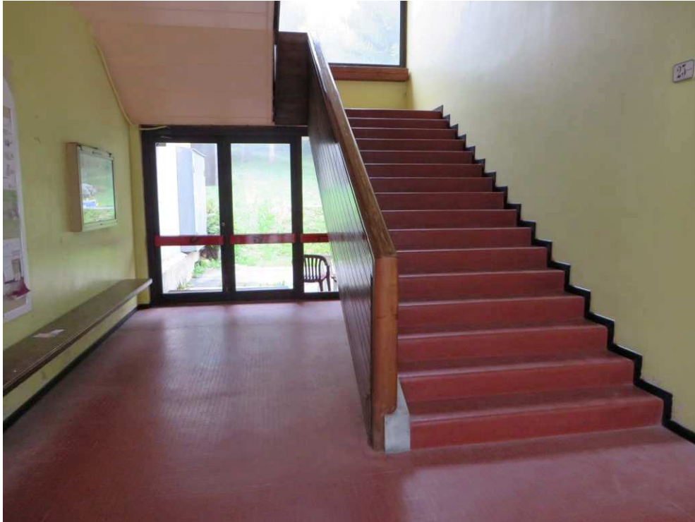
FOTO 5: VANO SCALE CONDOMINIALE
