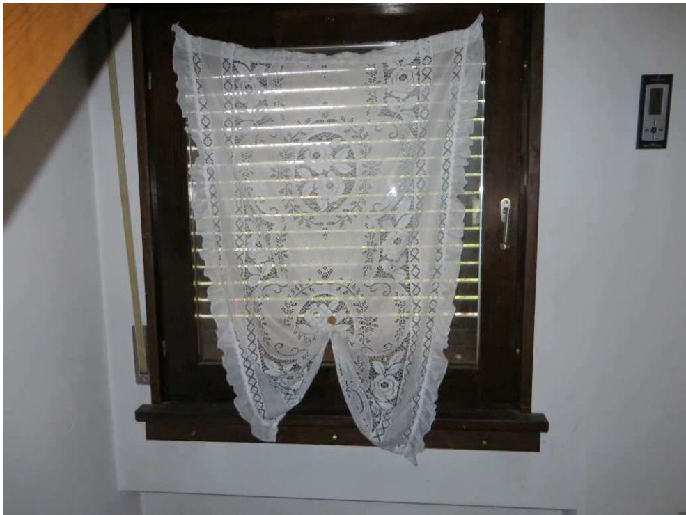
FOTO 18: SERRAMENTO DELLA CAMERA (SUB. 16 AL 2° P.)
