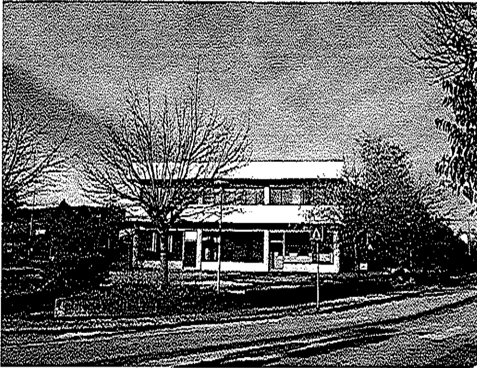
Foto n. 1 –Bene oggetto del pignoramento ( lato sud ) con antistante area pavimentata ed aiuole a verde con alberature.
